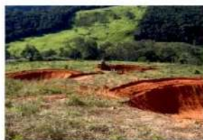
Fig. 1: Barraginhas em construção
