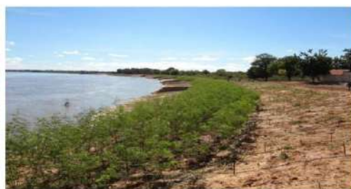
Fig. 4 – Área em processo de estabilização após 12 meses. (fonte: AR/GSA/UCF, 2013)
