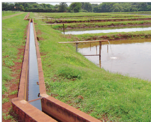
FIGURA 15 - Sistema de Abastecimento
