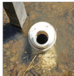
C) Tubo de 100mm com redução para 50mm
