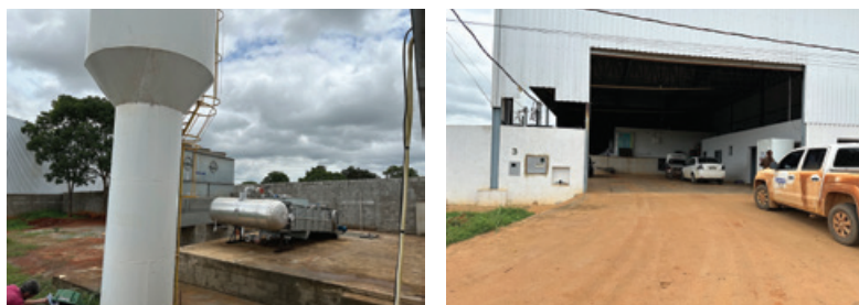
Figura 21 – Fábrica de gelo situada no município de Morada Nova de Minas/MG
