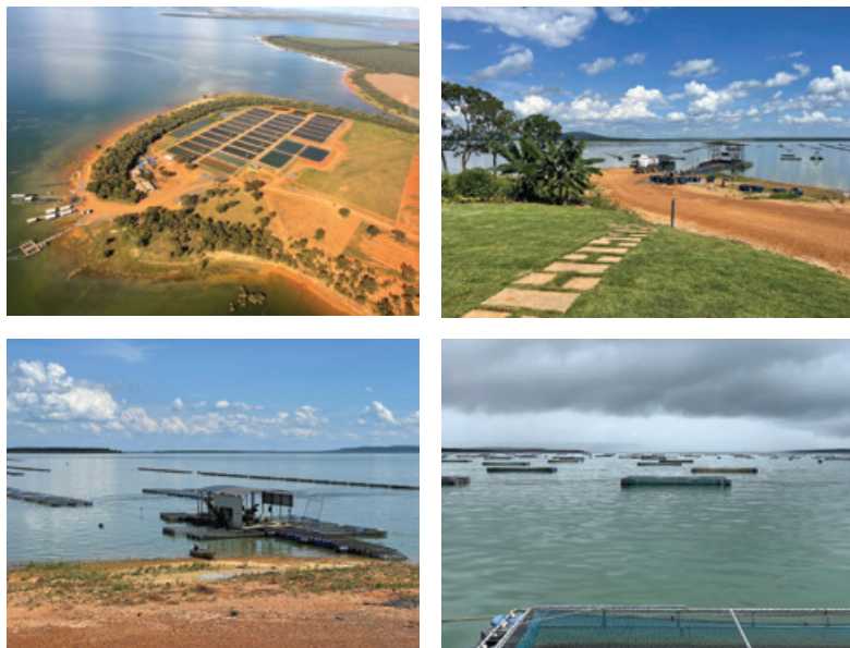
Figura 4 – Vista aérea do empreendimento de aquicultura em tanques rede e de tanques escavados em terra para alevinagem da Empresa Profish Ltda., em Morada Nova de Minas/MG
