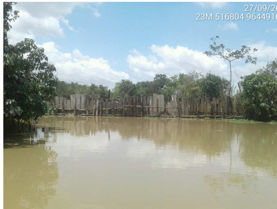
Foto 32 - Barreira construída pela população local para impedir a entrada da água salgada no rio na área amostral A4 (ADA)
