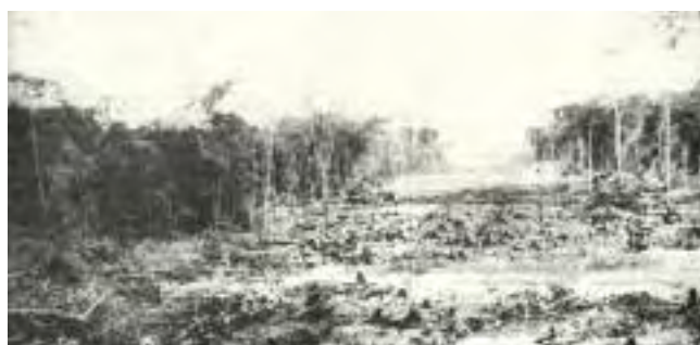
Figura 5. O início das obras da BR-163 (1972).
