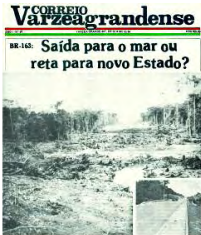
Figura 13. A inauguração do asfalto da BR-163 em Mato Grosso.
