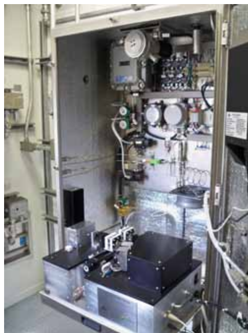
Analisador de processo baseado em Espectroscopia no Infravermelho Próximo (NIR) para monitoramento de hidrocarbonetos derivados do petróleo
