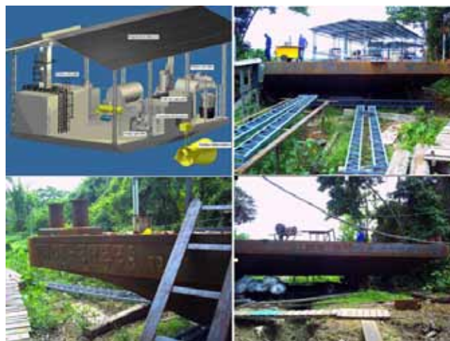
Sistema híbrido flutuante para geração de eletricidade
