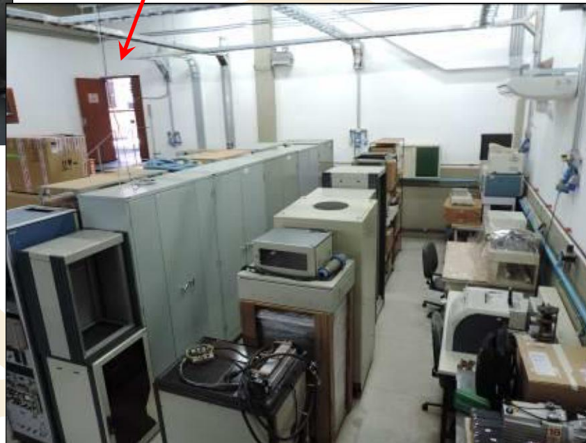
Porta de acesso externo ao subsolo
