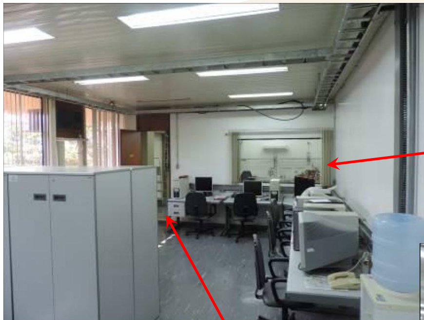
SALA DE CONTROLE Vista a partir da porta de entrada desta sala
