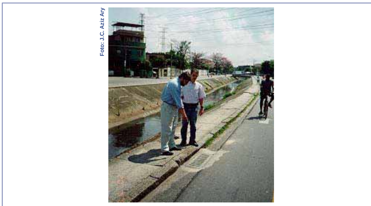
FIGURA 168- Exemplo de posicionamento correto de grelha na ciclofaixa no Jardim das Américas, no Rio de Janeiro/RJ.
