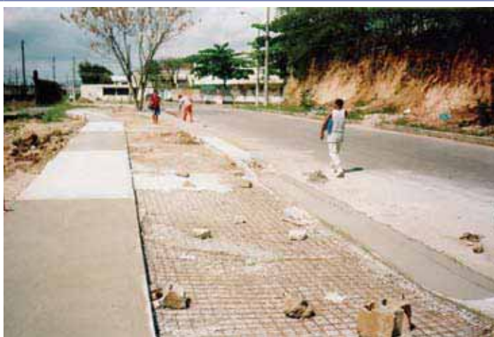
FIGURA 153 - Reforço da base do pavimento em área de cruzamento de veículos sobre a ciclovia em construção em Campo Grande/RJ.
