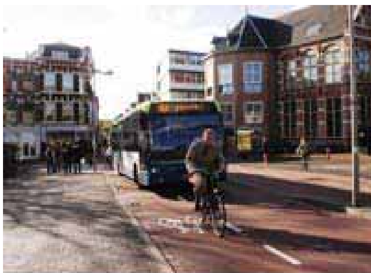
FIGURA 90 - Ciclofaixa implantada em trecho de via com reduzida largura de pista, Leiden, Holanda, 2006.
