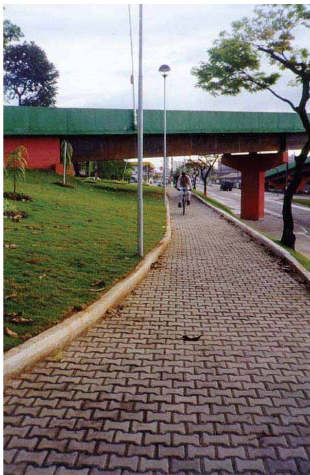
FIGURA 159 - Pavimentos de ciclovias com blocos pré-moldados de concreto em Volta Redonda/RJ.
