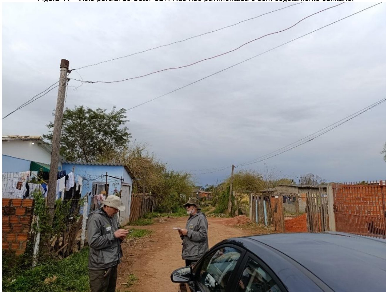
Figura 41 - Vista parcial do Setor S27. Rua não pavimentada e sem esgotamento sanitário.
