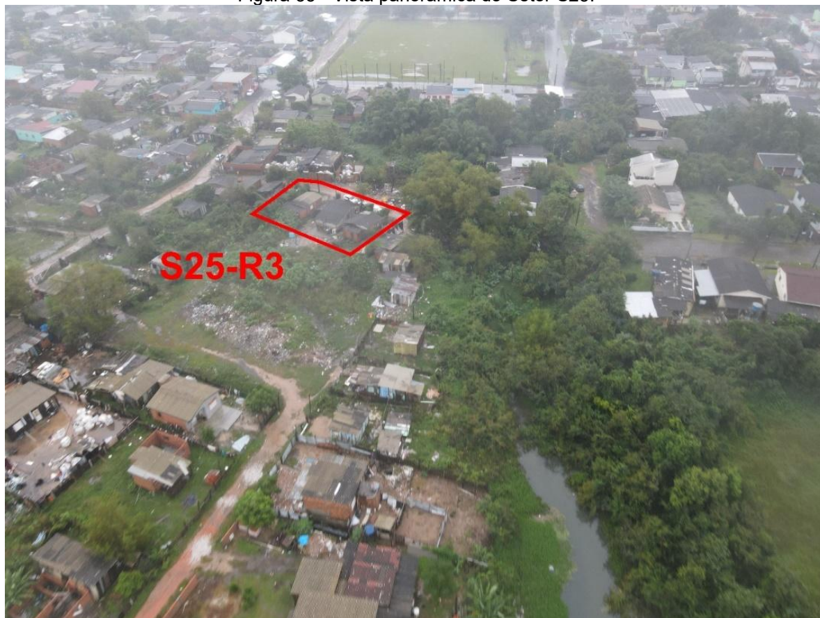
Figura 35 - Vista panorâmica do Setor S25.
