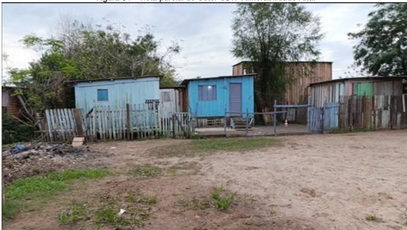
Figura 54 - Vista parcial do Setor S31. Vulnerabilidade Alta.
