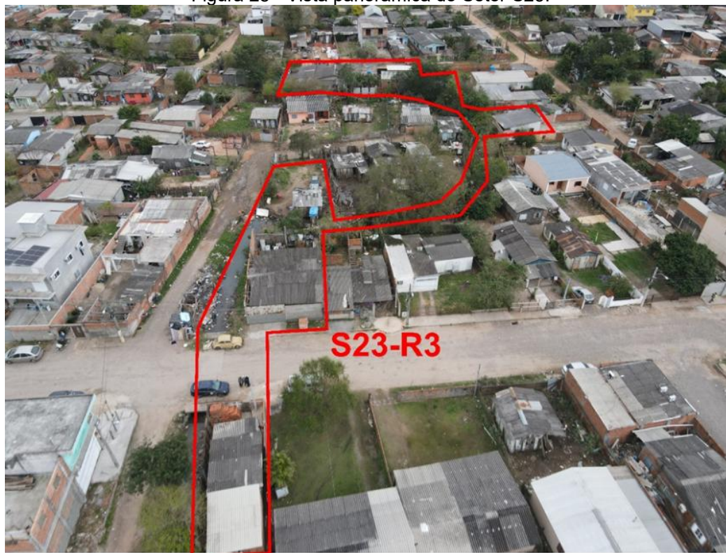
Figura 28 - Vista panorâmica do Setor S23.
