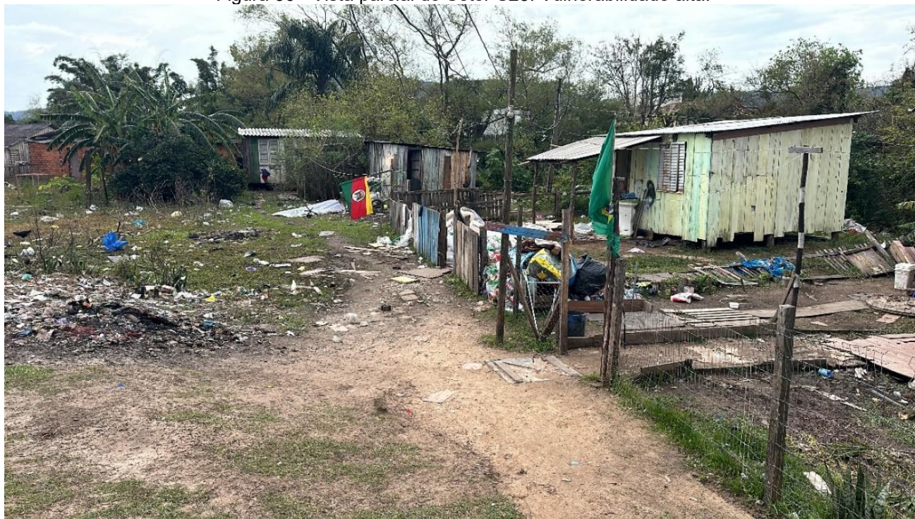
Figura 36 - Vista parcial do Setor S25. Vulnerabilidade alta.
