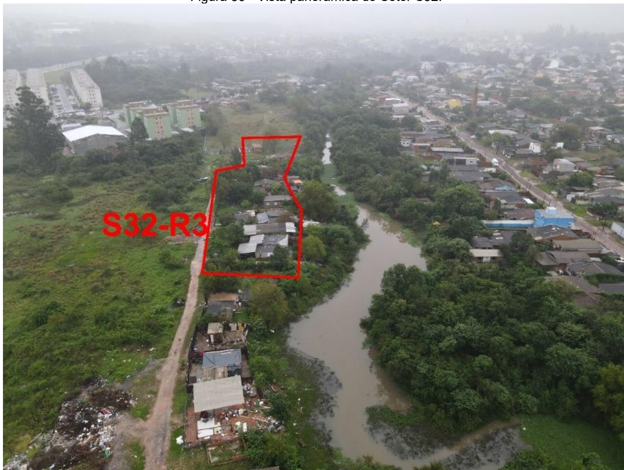
Figura 56 - Vista panorâmica do Setor S32.
