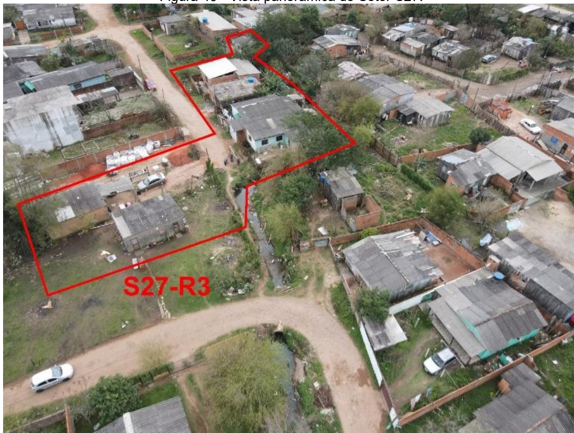
Figura 40 - Vista panorâmica do Setor S27.
