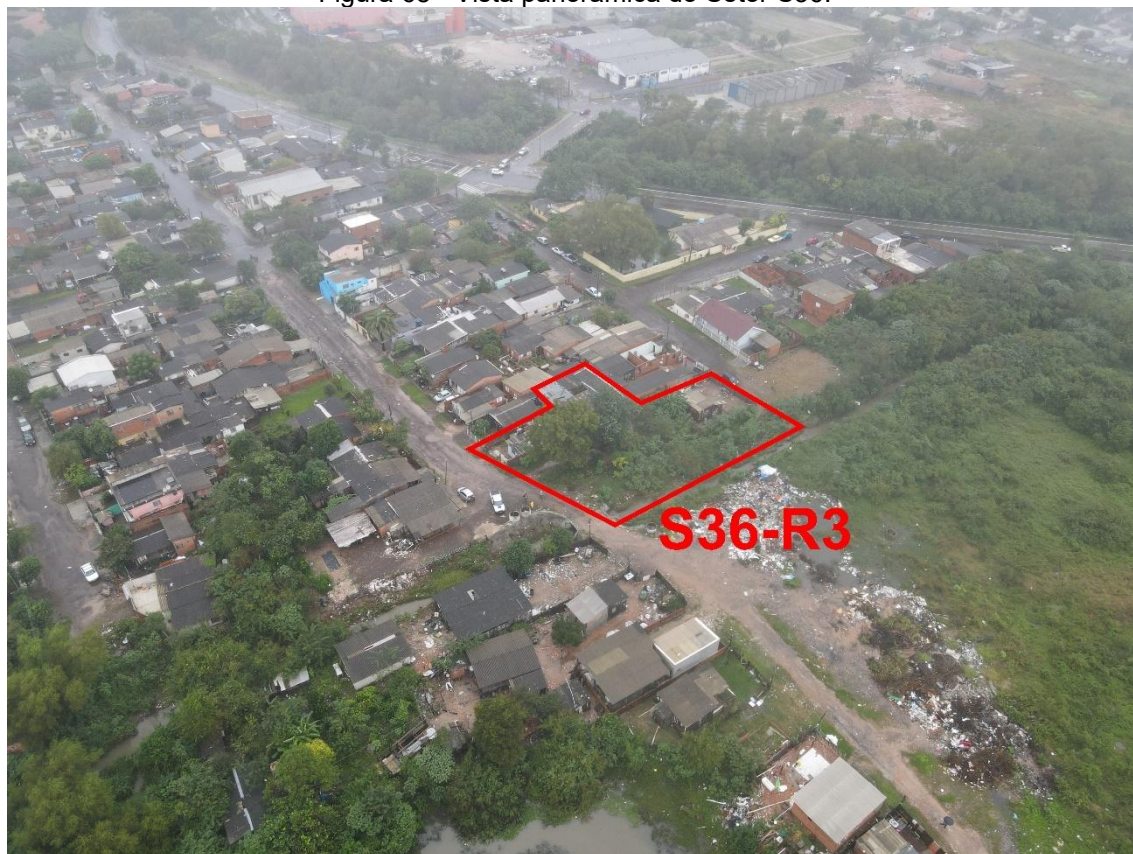
Figura 68 - Vista panorâmica do Setor S36.
