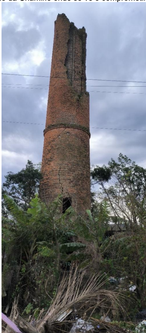
Figura 73 - Detalhe da Chaminé onde se vê o comprometimento da estrutura.
