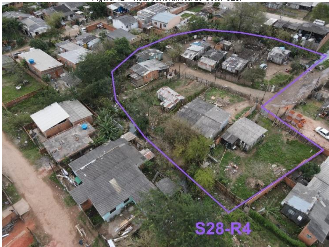
Figura 42 - Vista panorâmica do Setor S28.
