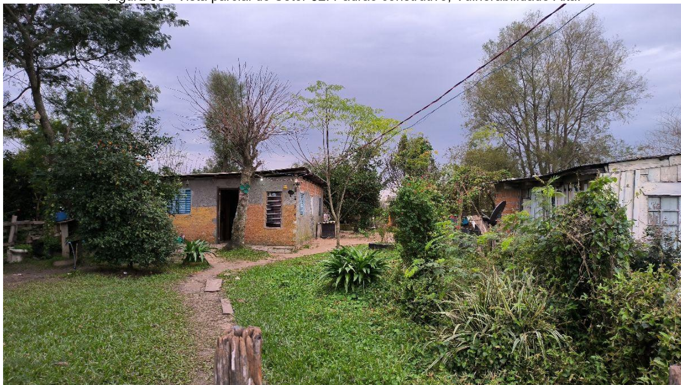
Figura 58 - Vista parcial do Setor 32. Padrão construtivo, Vulnerabilidade Alta.
