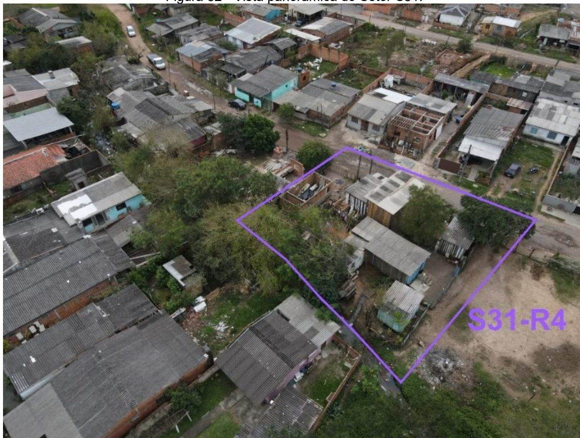
Figura 52 - Vista panorâmica do Setor S31.
