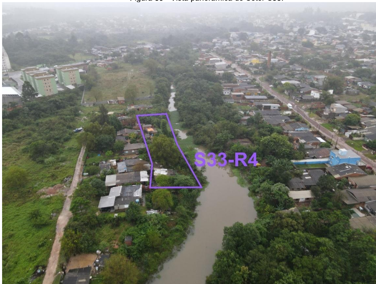
Figura 59 - Vista panorâmica do Setor S33.
