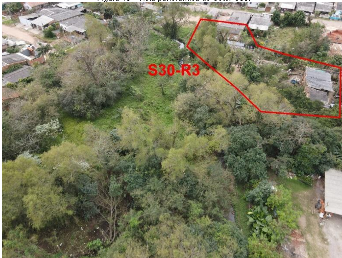
Figura 49 - Vista panorâmica do Setor S30.
