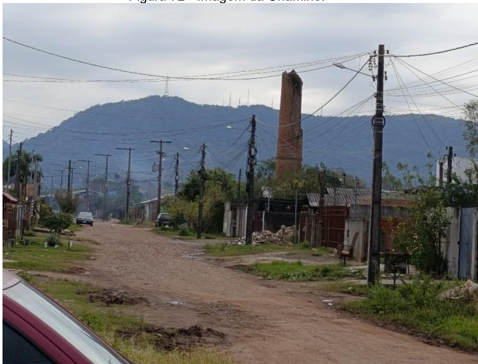
Figura 72 - Imagem da Chaminé.
