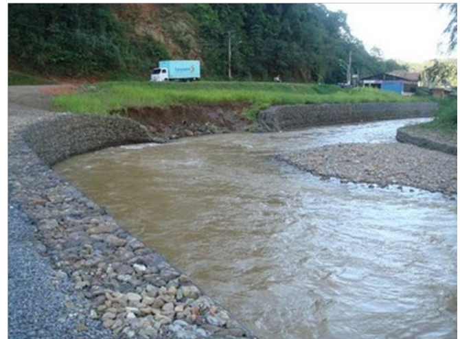
Figura 29 - Exemplos de uso de muros de gabião, com e sem sucesso e representação esquemática de um muro de gabião na porção superior direita da figura.
