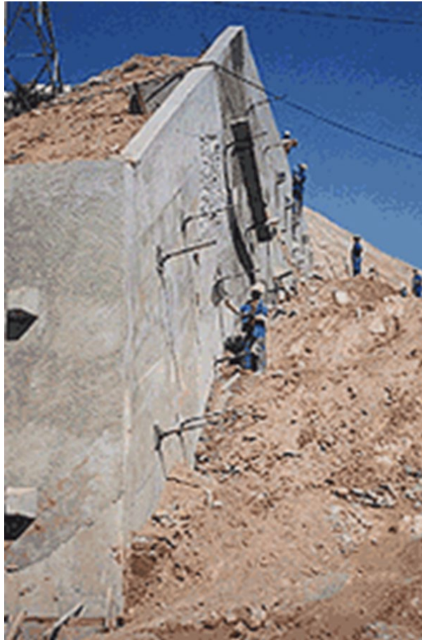
Figura 31 - Execução de uma cortina atirantada.
