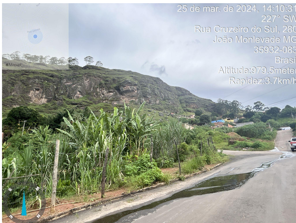
Figura 8 - Vistas parciais do movimento de massa (deslizamento circular) ocorrido na Avenida Alberto de Lima, no bairro Paineiras, João Monlevade. Em (a) vista de montante para jusante, mostrando a avenida Alberto Lima e o Atacado Mart Minas. Em (b) vista parcial da porção superior da cicatriz do escorregamento e, em (c), outra visada da porção superior da cicatriz com várias tubulações de águas servidas rompidas.
