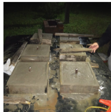
Preparação dos marcos superficiais
