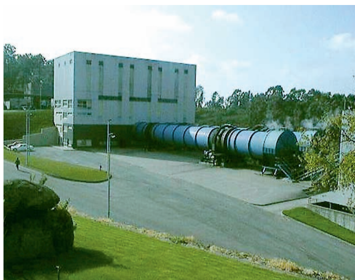
Figura 16 - Método acelerado de compostagem em reatores rotatórios. Sistema Dano - Riba d'Ave (GRS/UFPE, 2012)
