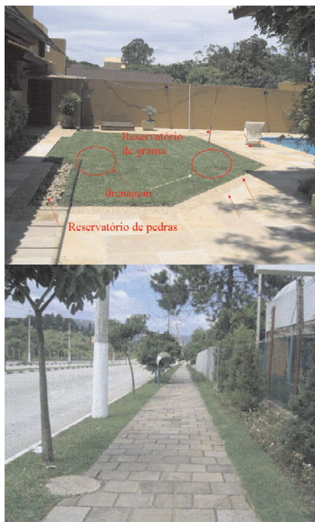
Figura 3.22 Uso de dispositivos para reter a água de áreas impermeáveis: (a) foto da esquerda mostra as áreas drenadas de pavimentos para o gramado e dos telhados para reservatórios de pedra; (b) calçadas com gramas laterais para aumentar a infiltração.
