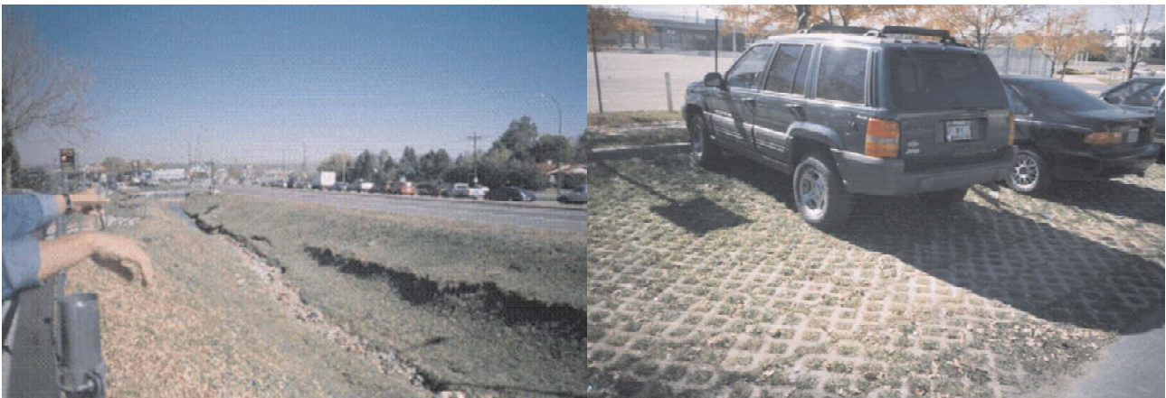
Figura 3.23 Foto da esquerda mostra exemplo de valo de infiltração, enquanto a foto à direita apresenta pavimento permeável com blocos vazados em estacionamento.
