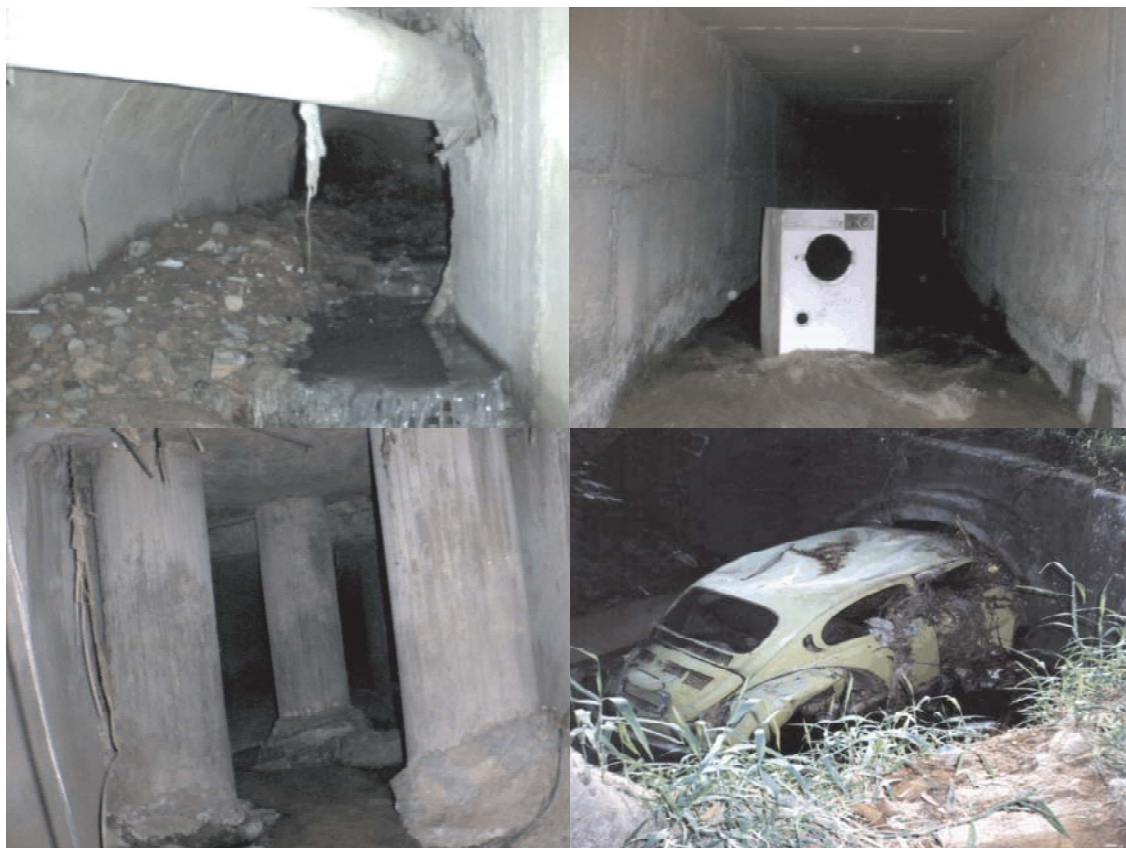
Figura 3.7 Obstrução e resíduo na drenagem (Belo Horizonte e São Paulo)
