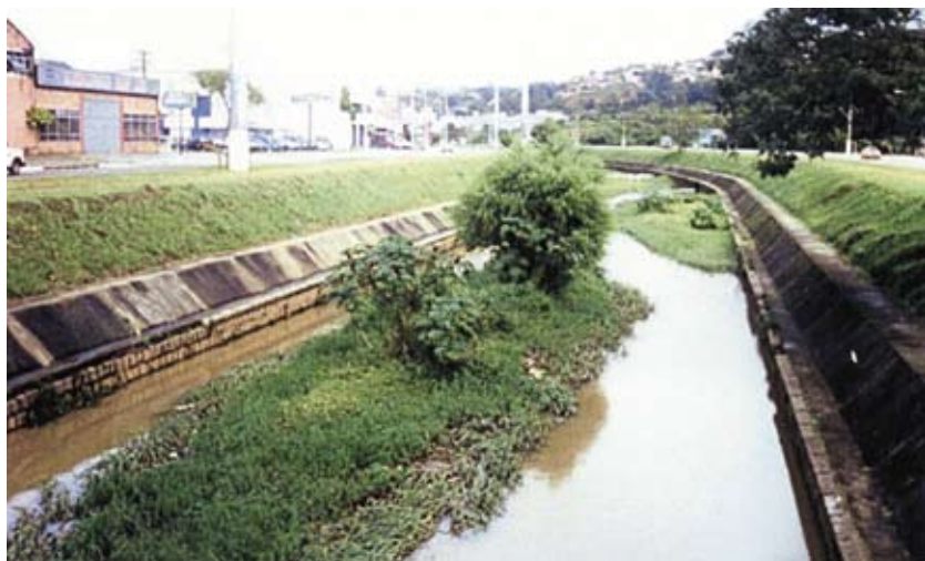
Figura 5.4. Assoreamento da macro-drenagem urbana.
