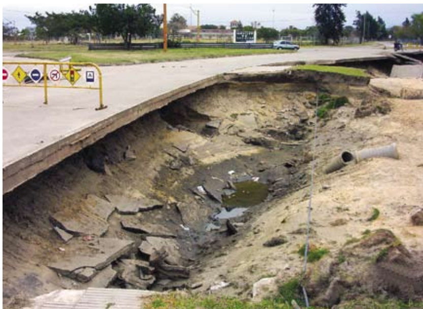
Figura 5.15. Destruição da infra-estrutura urbana devido à inundação.
