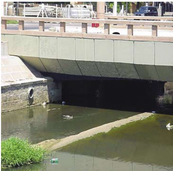
Figura 5.5. Obstrução ao escoamento por projetos mal concebidos.
