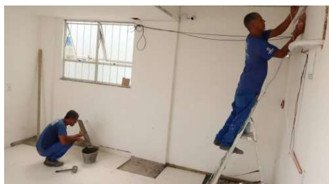
Hospital Luiz Palmier moderniza instalações
