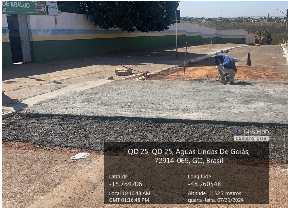
Figura A1 – Execução de faixa elevada.
