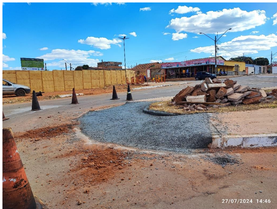
Figura A2 – Rebaixamento para implantar a ciclovia.
