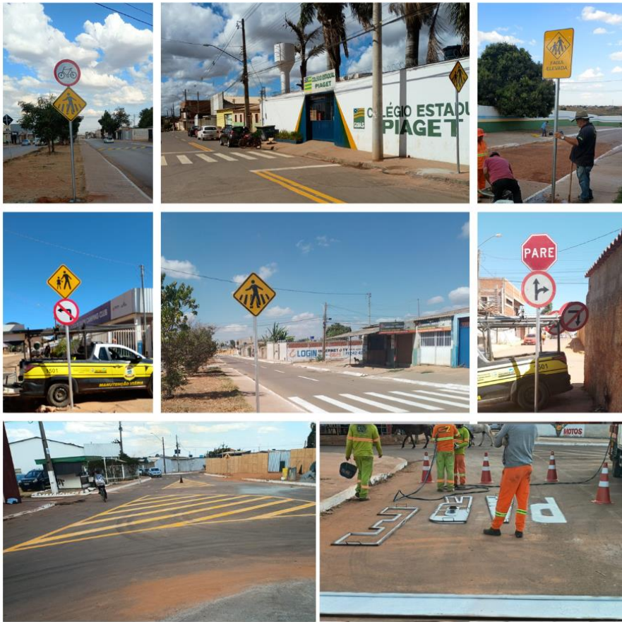
Figura A3 – Execução da sinalização.
