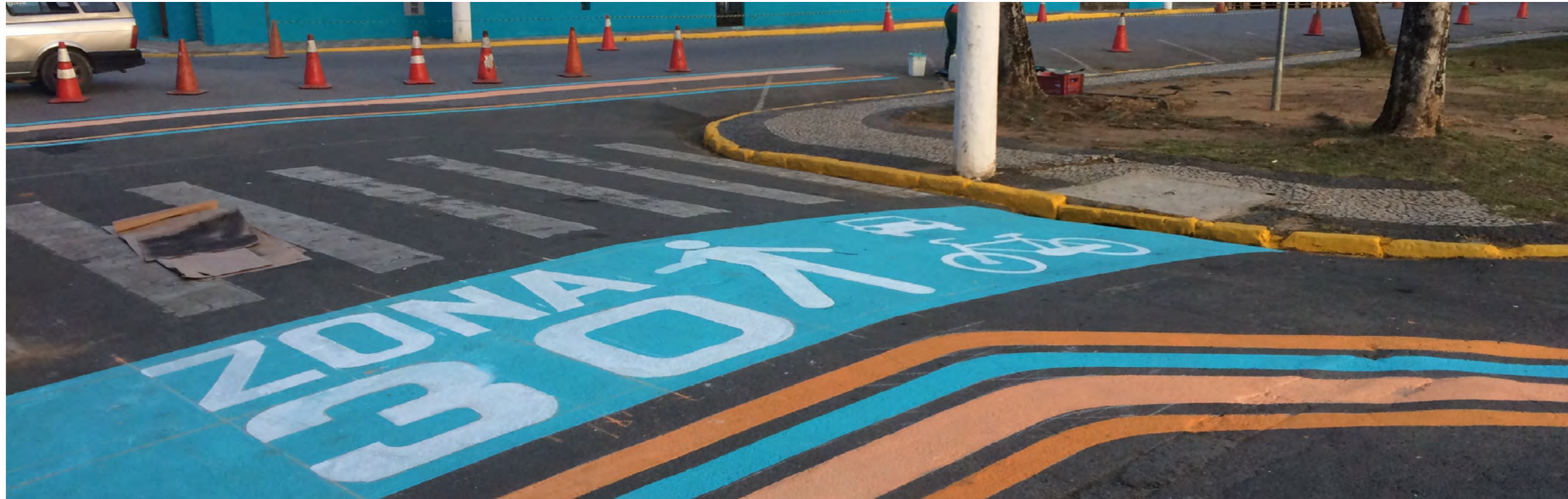
Demarcação de piso e sinalização horizontal [realizado pela equipe da Iniciativa] e início da demarcação da ciclofaixa [realizada pela equipe da Prefeitura Municipal].
