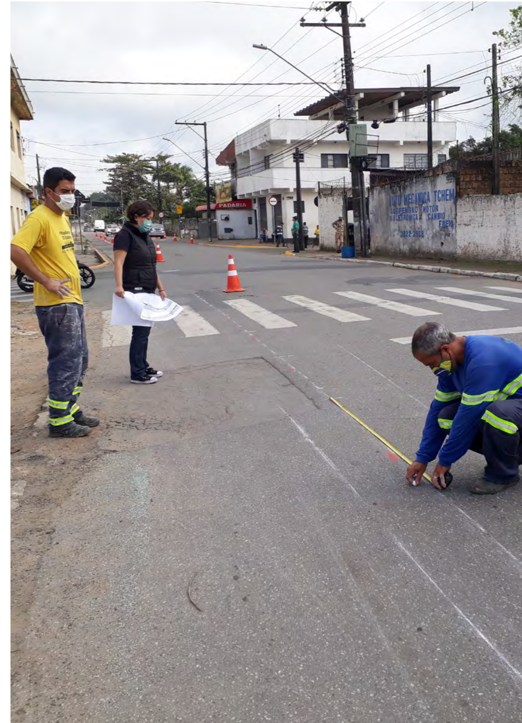
Demarcação da ciclofaixa, executada pela equipe técnica da Prefeitura Municipal. Crédito: Cidade Ativa, 2022
