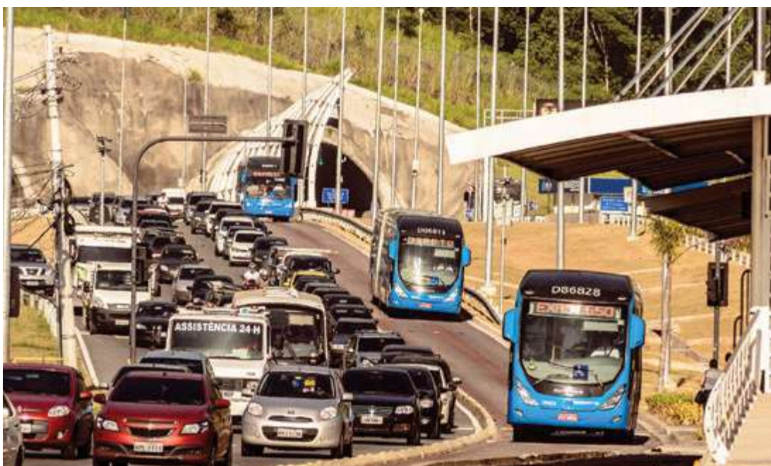
Figura 13 – BRT TransOeste, no Rio de Janeiro/RJ.
