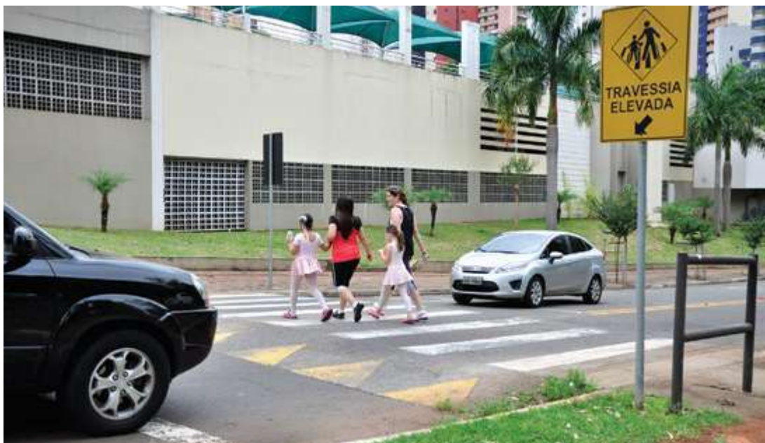
Figura 42 – Travessia elevada, Londrina/PR.
