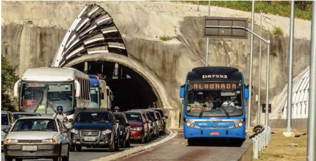
Figura 46 – BRT TransOeste, no Rio de Janeiro/RJ.
