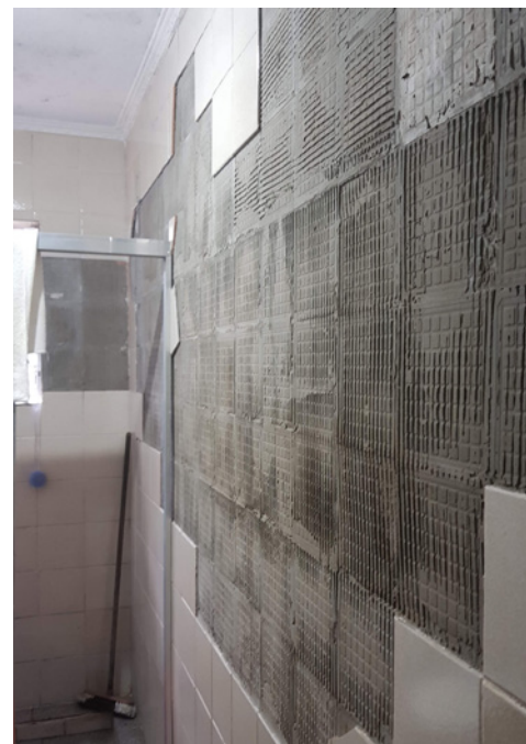
↓ Imagem: Descolamento ou deslocamento causado pela falta de aderência à base. Isso pode ocorrer pelas condições climáticas, falhas no assentamento ou pela qualidade da argamassa. É muito comum em revestimentos cerâmicos e podem causar destacamentos, quando há perda de aderência da argamassa colante e as placas se soltam, podendo causar acidentes.
