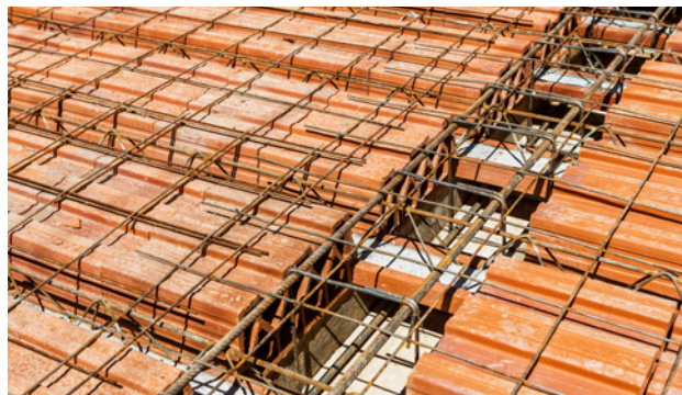
← Imagem: Laje treliçada com blocos cerâmicos.
