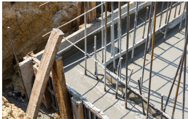
← Imagem: Execução de vigas baldrame (fundação).
