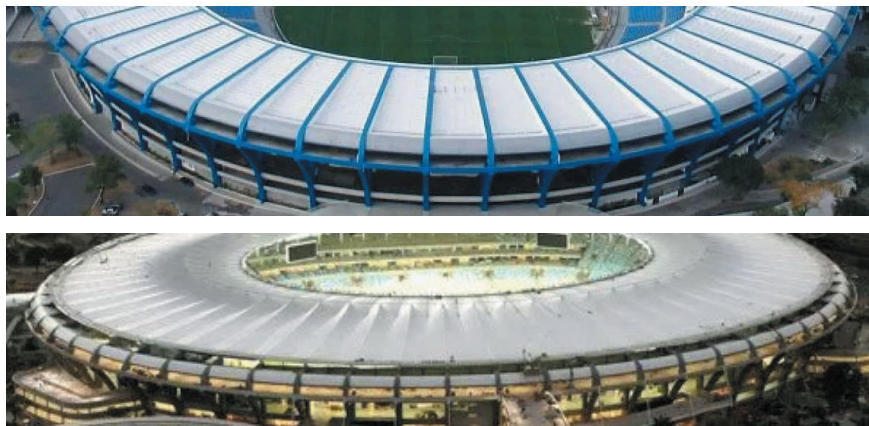
Figura 13 – Marquise do Maracanã antes e depois da reforma.
