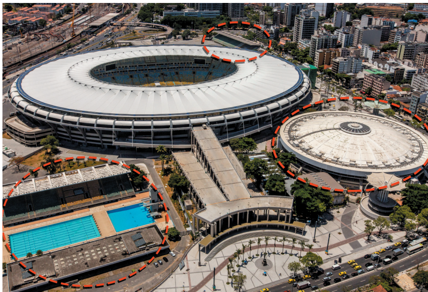
Figura 8 - Complexo Maracanã (Ao fundo à esquerda Parque de Atletismo; à frente à esquerda Maracanãzinho; à frente à direita Parque Aquático)
