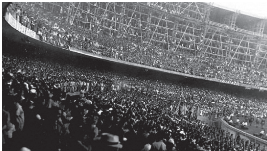
Figura 18 - Maracanã em 1950 com 200 mil pessoas. Andaimes e improviso
