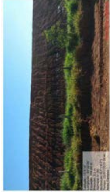
Talude de jusante da barragem Campos com erosões superficiais e destaque para a linha de saturação. / Foto: ANM
