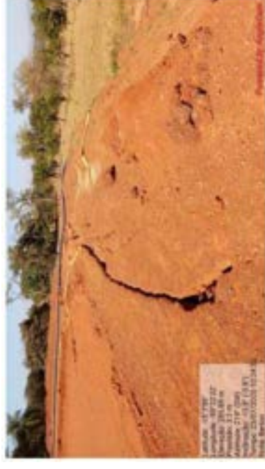
Trincas encontradas na crista da barragem Berion e borda livre insuficiente. Foto: ANM
