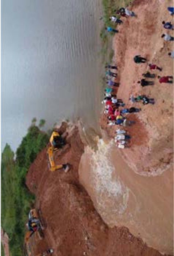
Abertura emergencial de canal extravasador na barragem de Granjeiro (2019) Foto: Prefeitura Municipal de Ubajara/CE
