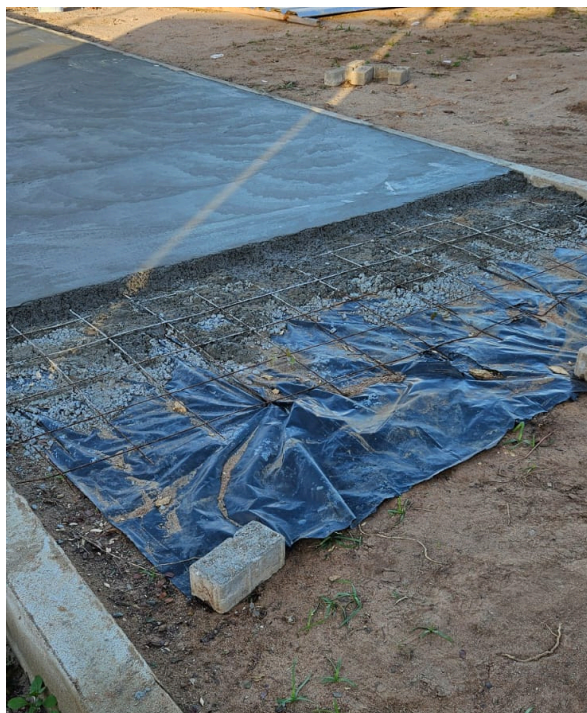
Figura 21 - Ausência da 1ª camada de concreto magro na Pista de Caminhada
