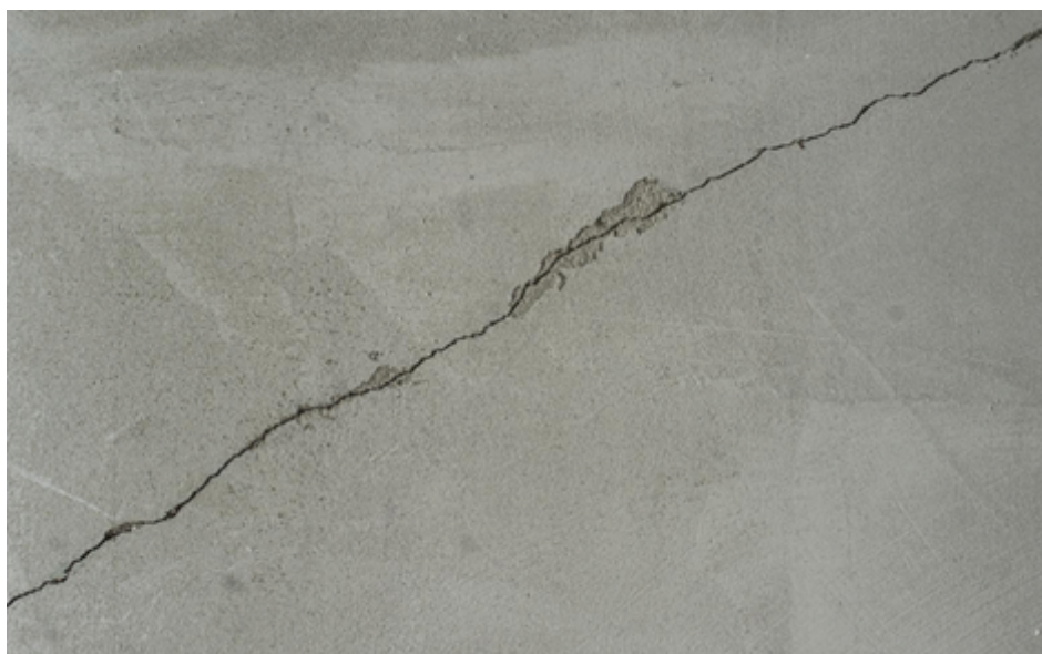
Figura 22 - Trincas em calçadas de concreto
