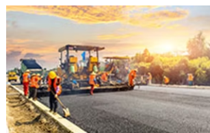
EXECUÇÃO DE OBRAS
