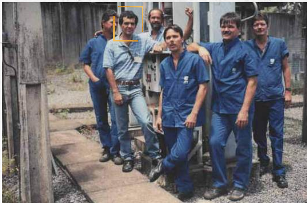
Dorival (de camisa listrada) com colegas da equipe de subestação, início dos anos 90.
