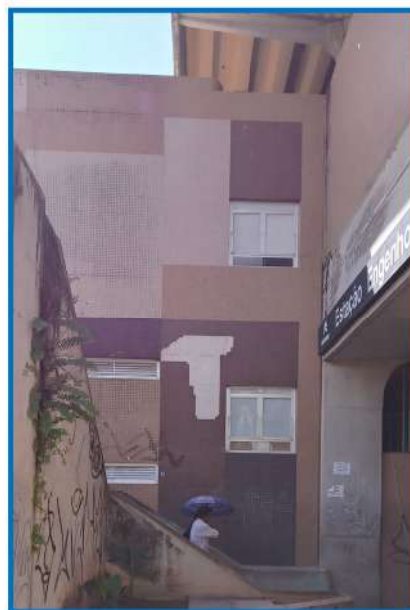
Rejunte comprometido Áreas externas sem revestimento
