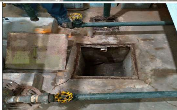
Tubulação drenagem da casa de Bombas entupida e Grelha do extravasor oxidada
