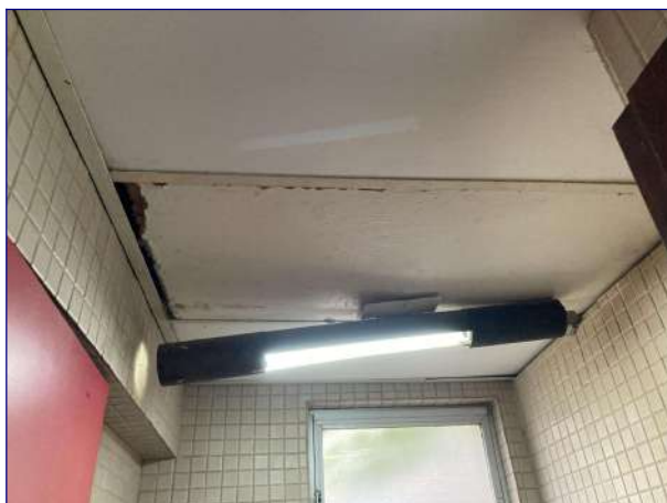
Forro Pacote deteriorado
