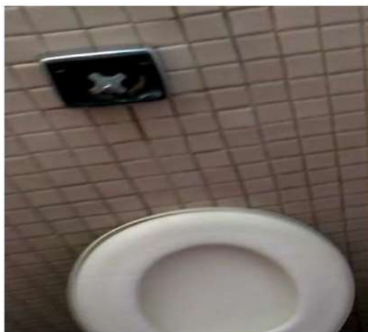
Falta acabamento do registro da válvula de descarga no banheiro masculino
