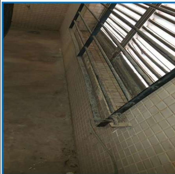
Rejunte comprometido Áreas externas sem revestimento
