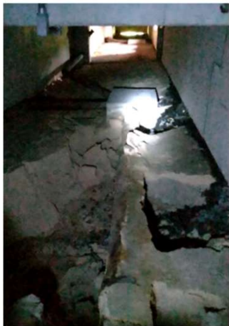
Caixas sob plataforma cedendo junto ao aterro
