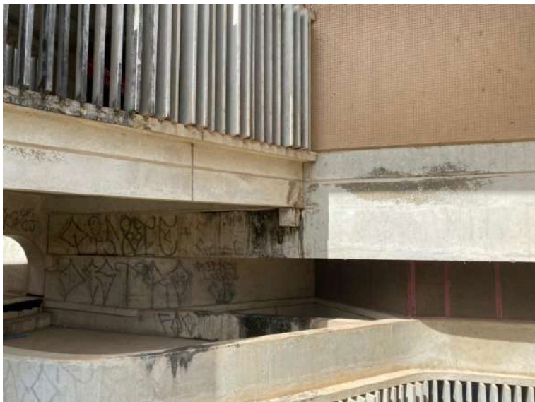
Vista do dente GERBER a ser recuperado na Estação Engenho Velho
