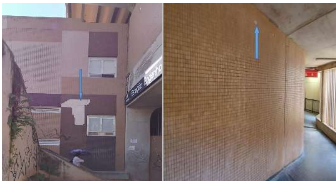
Exemplos de situações externas e internas com áreas sem revestimento na Estação Engenho Velho
