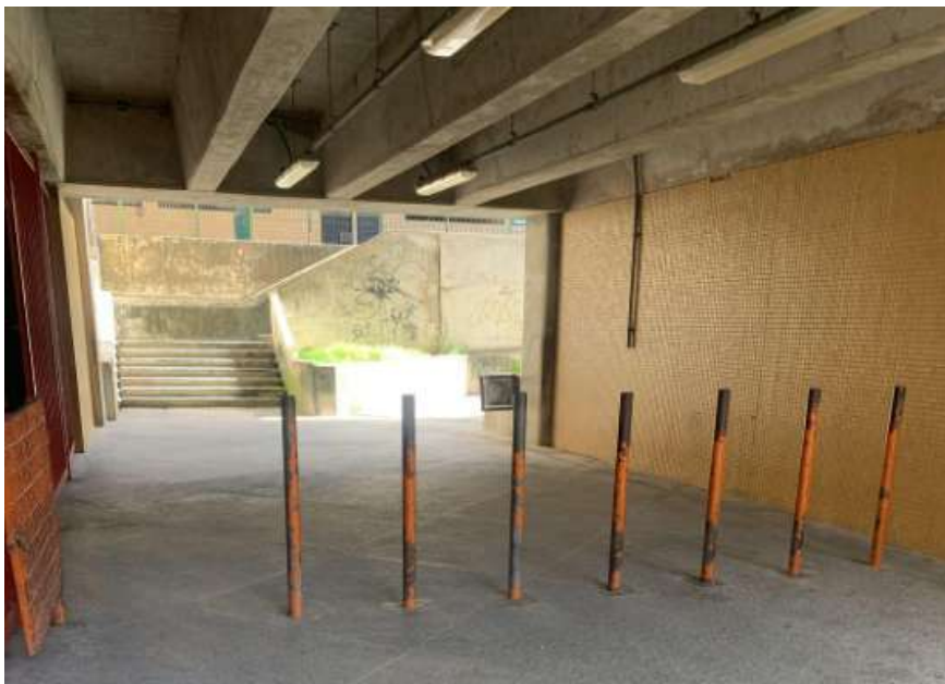
Vista geral dos pontaletes a serem substituídos na Estação Barro
