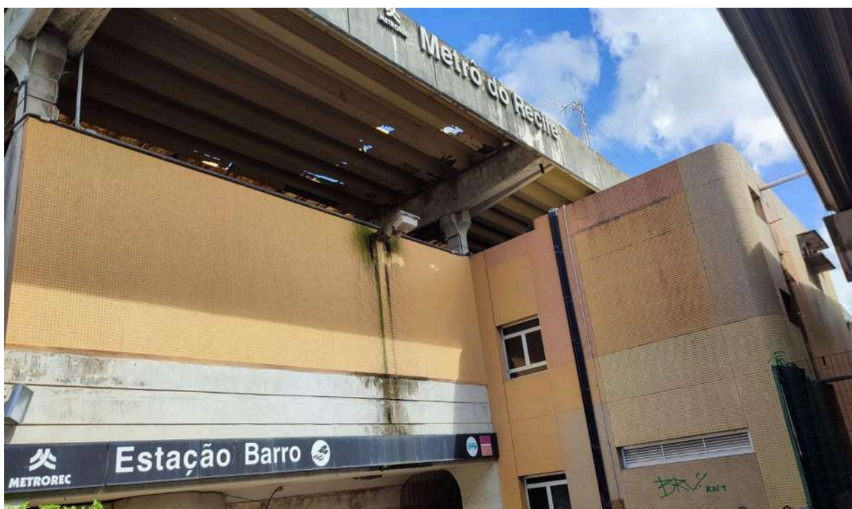
Situações onde se mostra a necessidade de limpeza do revestimento em pastilhas na Estação Barro
