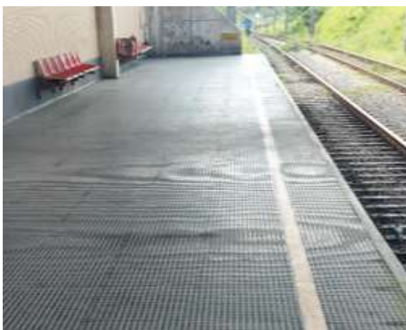
Faixa amarela de alerta a ser substituída na Estação Engenho Velho
