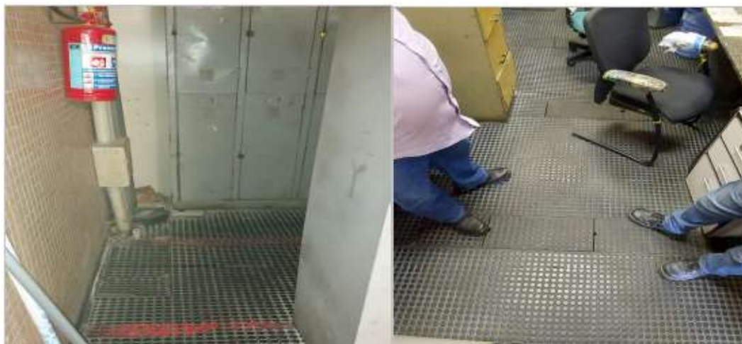
Emborrachados a serem removidos, aplicados sobre tampas de canaletas na Estação Engenho Velho
