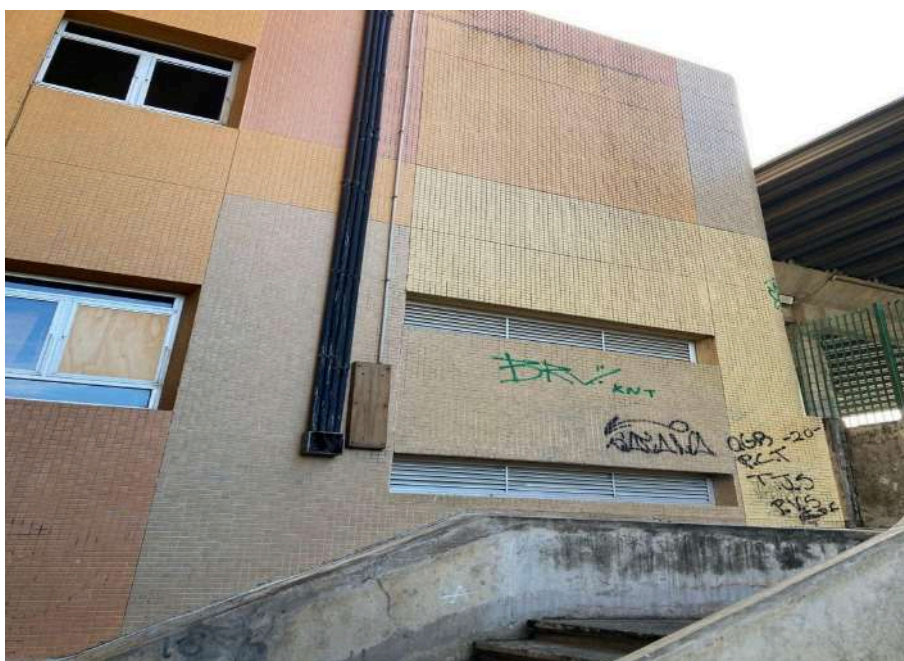
Situação de área com necessidade de recomposição de rejuntas na Estação Barro
