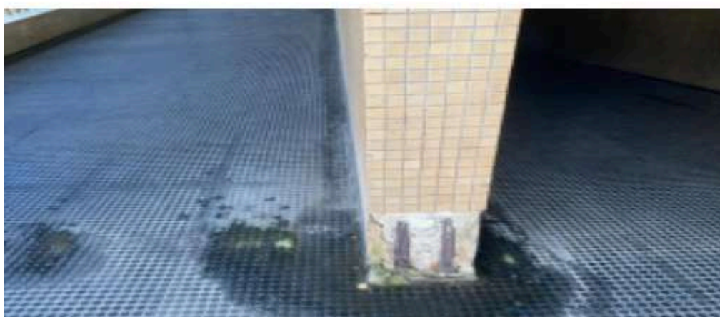
Situações onde os pilares serão recuperados e os rodapés substituídos na Estação Engenho Velho
