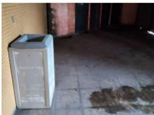
Exemplos de placas de piso emborrachado a serem substituídas na Estação Barro
