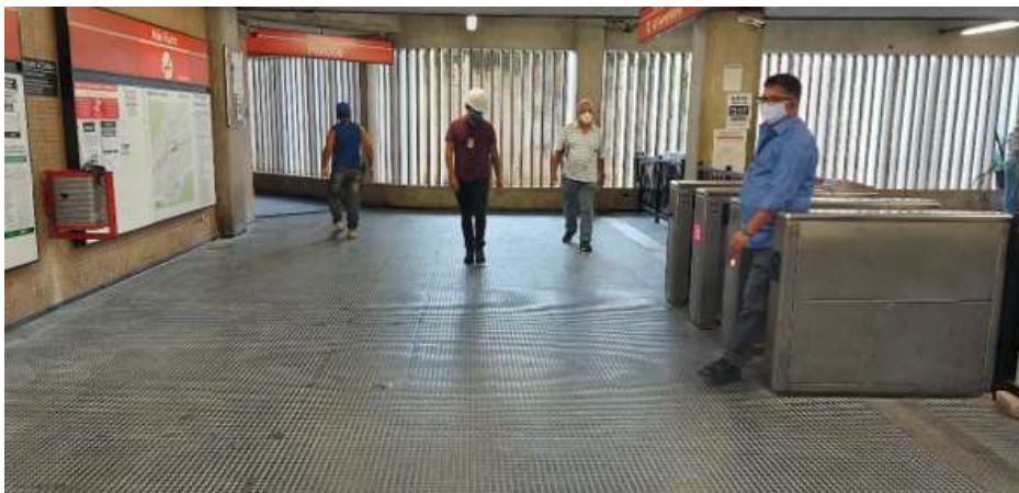
Vista geral do saguão em plurigoma na Estação Engenho Velho
