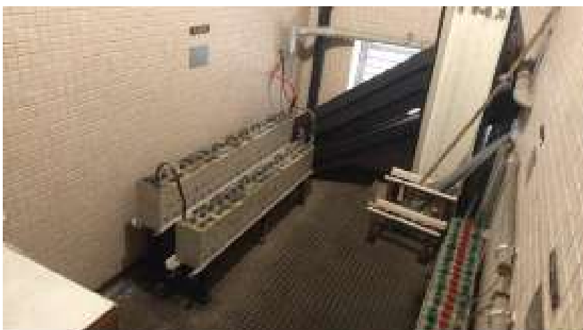
Sala de bateria desativada, onde se removerá pastilhas para reaproveitamento na Estação Engenho Velho
