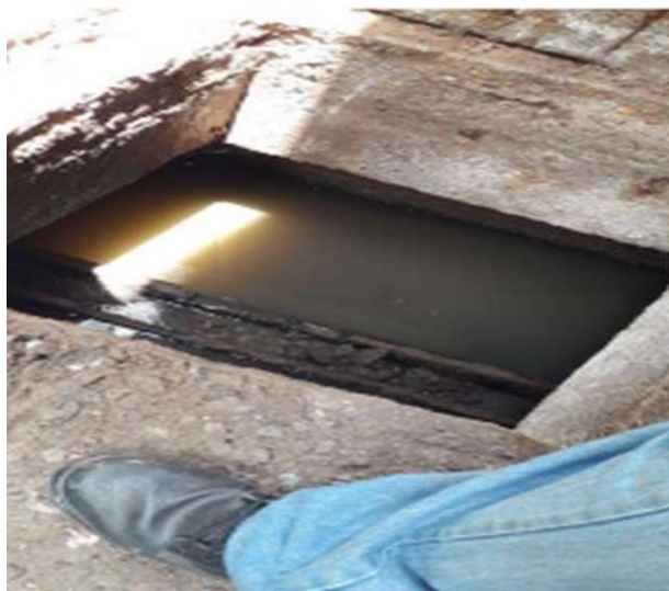
Vista do filtro anaeróbio a ser esgotado e limpo
