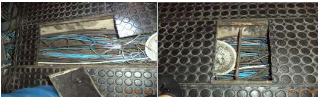
Vista geral de cantoneiras, nas canaletas de cabo, a serem substituídas
