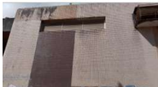
Situações onde se mostra a necessidade de limpeza do revestimento em pastilhas na Estação Engenho Velho
