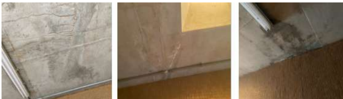
Imagem de áreas de lajes a serem tratadas na Estação Engenho Velho
