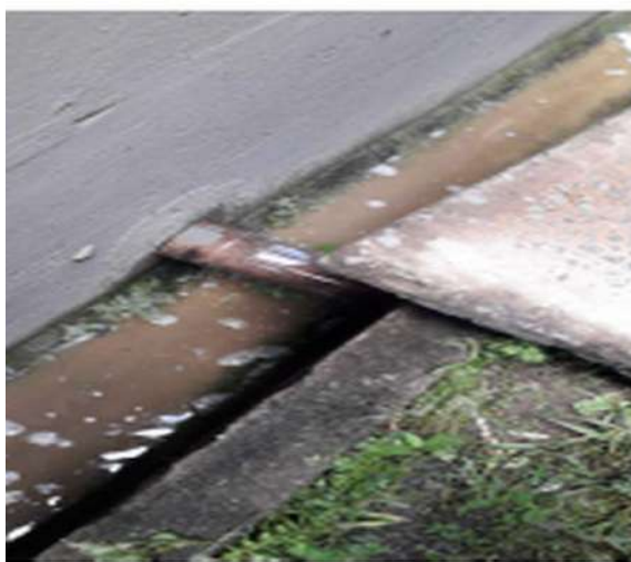
Tubulação de recalque danificada
