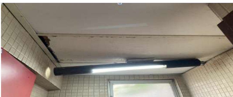
Exemplo onde o forro pacote será substituído por forro em PVC na Estação Engenho Velho
