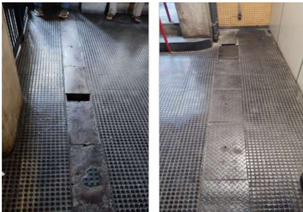
Emborrachados a serem removidos, aplicados sobre tampas de canaletas na Estação Barro
