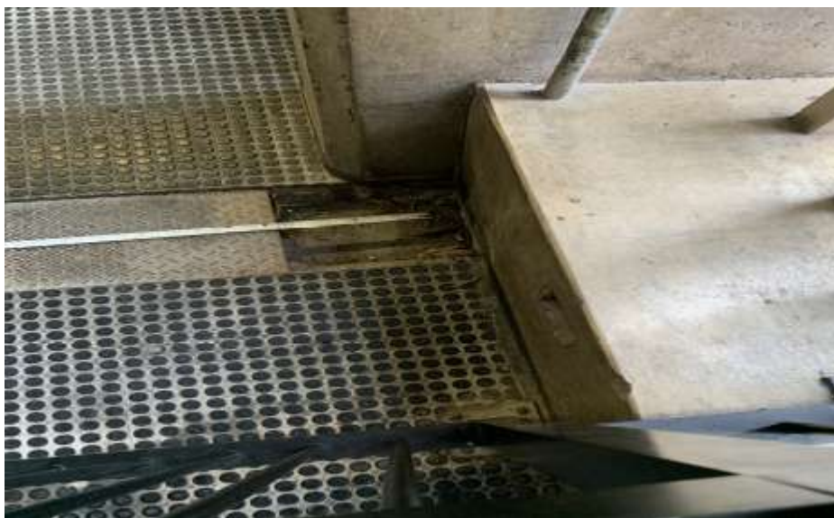
Vista geral de cantoneiras, nas canaletas de cabo, a serem substituídas
