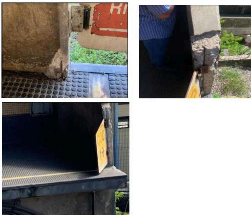
Vista geral das paredes de concreto a serem recuperadas na Estação Barro
