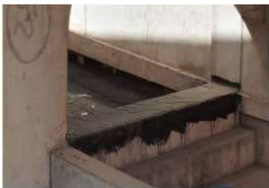
Laje de cobertura de uma das rampas de acesso a ser impermeabilizada na Estação Engenho Velho
