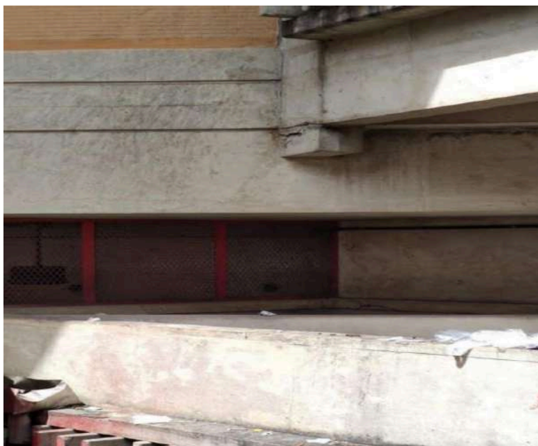
Vista do dente GERBER a ser recuperado na Estação Barro
