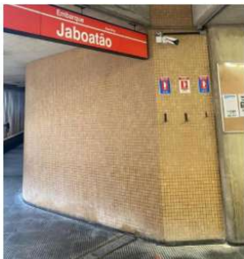
Imagem de juntas a serem substituídas no saguão da Estação Engenho Velho
