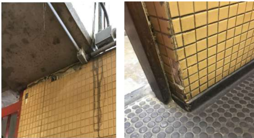
Exemplos de situações externas e internas com áreas sem revestimento na Estação Barro
