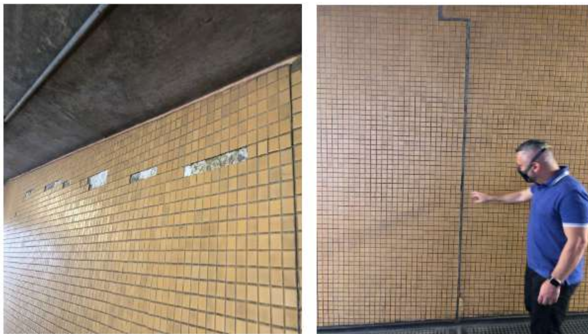
Imagem de juntas a serem substituídas no saguão da Estação Barro
