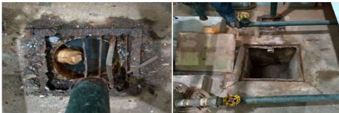
Grelha a ser substituída e sistema a ser desobstruído
