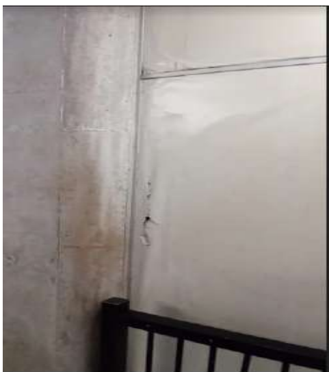
Vista de painel divisório danificado a ser substituído
