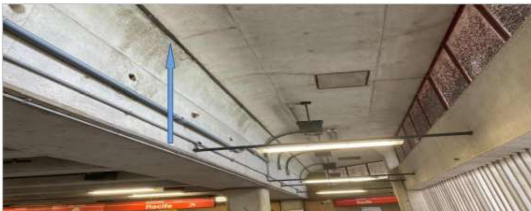
Vista de situação onde o mastique será substituído (saguão da Estação Engenho Velho)
