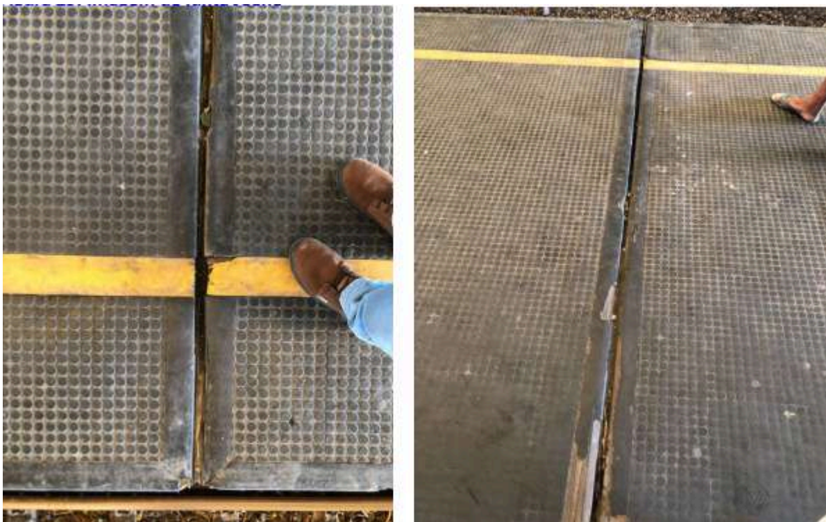
Imagem de juntas a serem substituídas no piso das plataformas da Estação Barro
