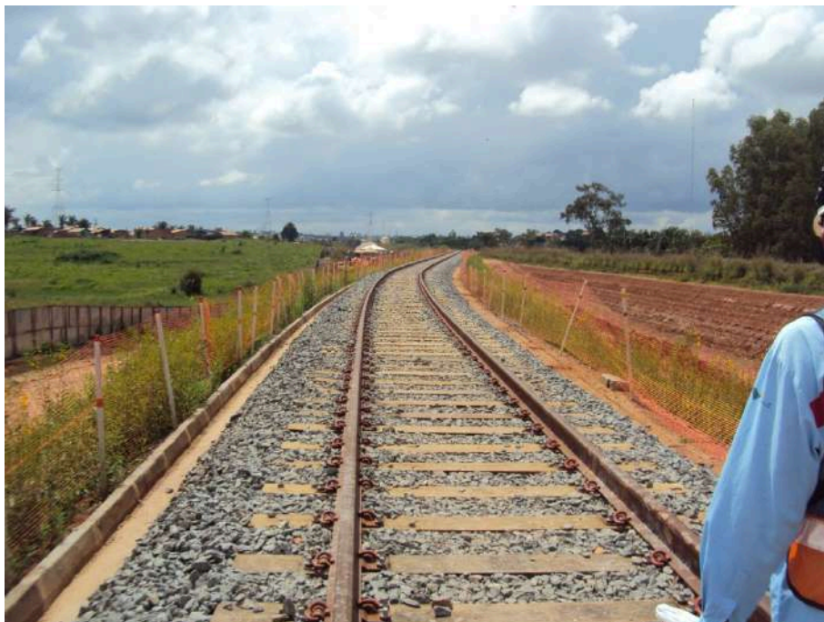
Exemplo de Obra ferroviária isolada por cerquites
