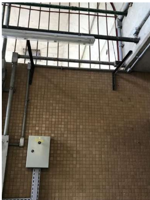
Vista geral de cantoneiras a serem removidas, fixadas sobre revestimento cerâmico na Estação Engenho Velho
