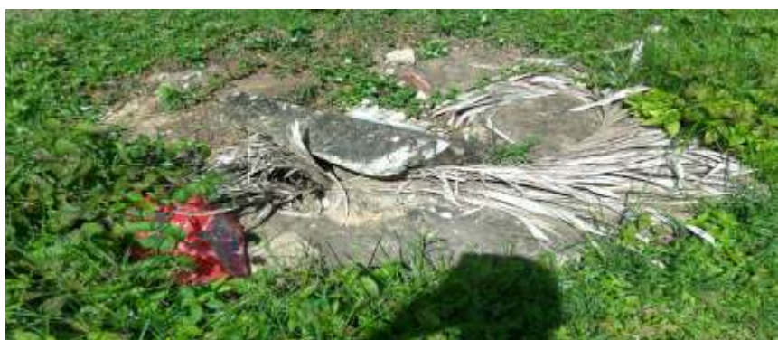
Tampa de concreto de poço de visita a ser substituída
