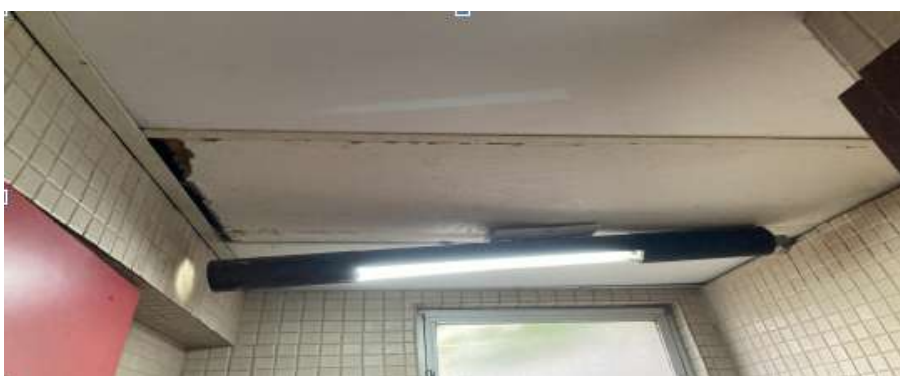
Exemplo onde o forro pacote será substituído por forro em PVC na Estação Engenho Velho
