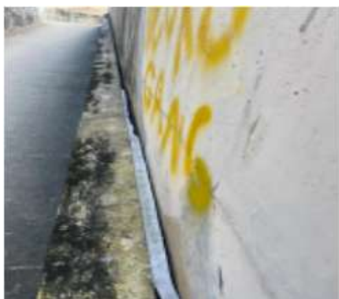
Vista geral das Juntas a serem tratadas na Estação Engenho Velho
