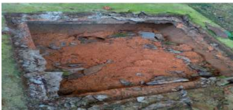
Caixa do sistema de drenagem a ser desobstruída
