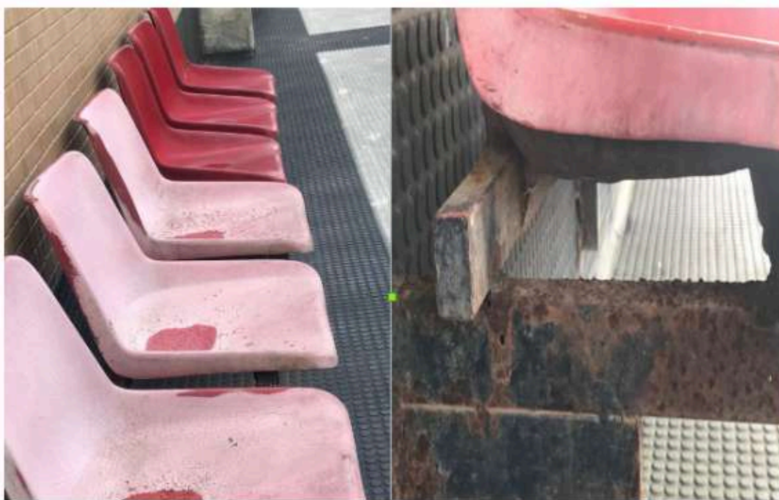
Vista de cadeiras de plataforma e suportes a serem removidas na estação Engenho Velho
