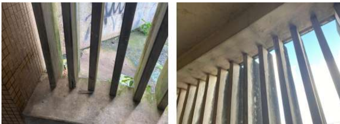
Vista geral dos brises a serem recuperados na Estação Engenho Velho
