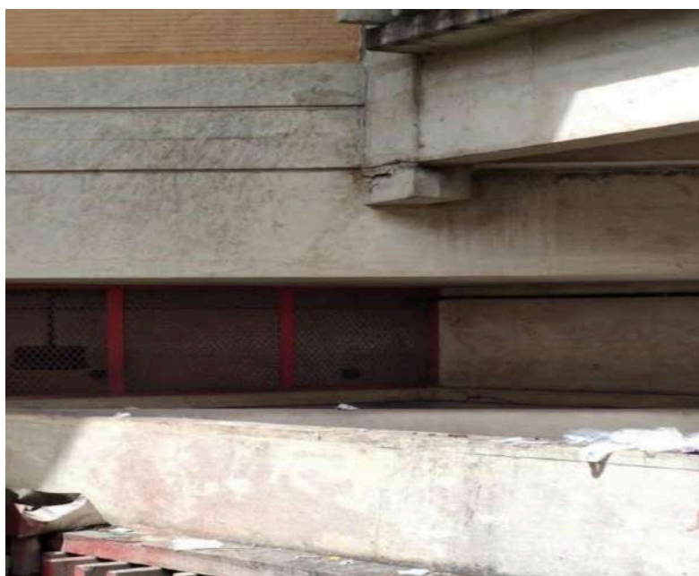
Vista do dente GERBER a ser recuperado na Estação Engenho Velho
