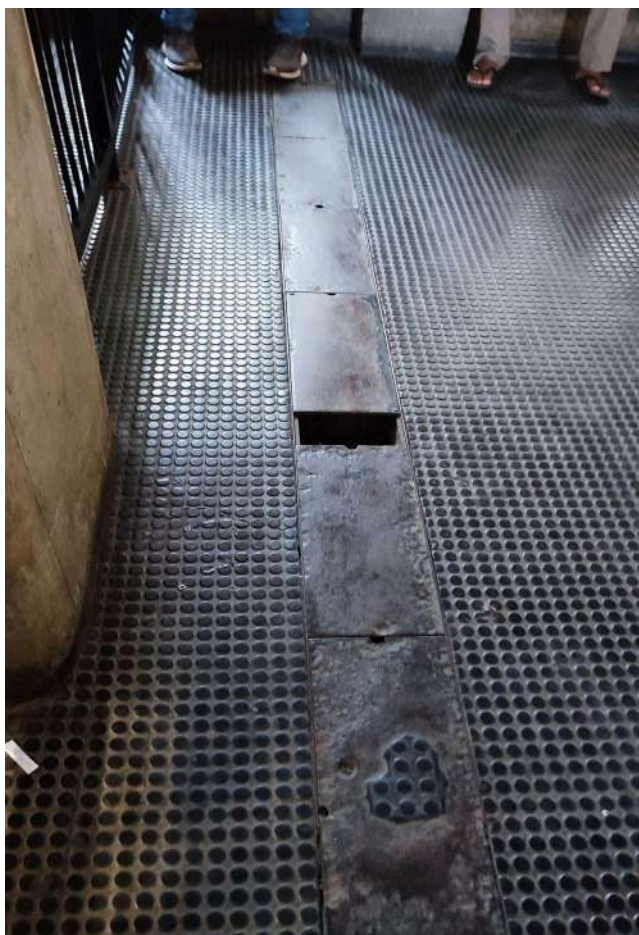
Vista geral de tampas de canaleta com piso emborrachado a ser removido na Estação Barro
