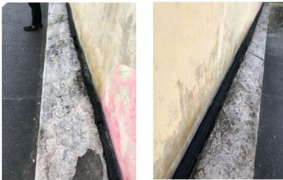
Vista geral das Juntas a serem tratadas na Estação Barro
