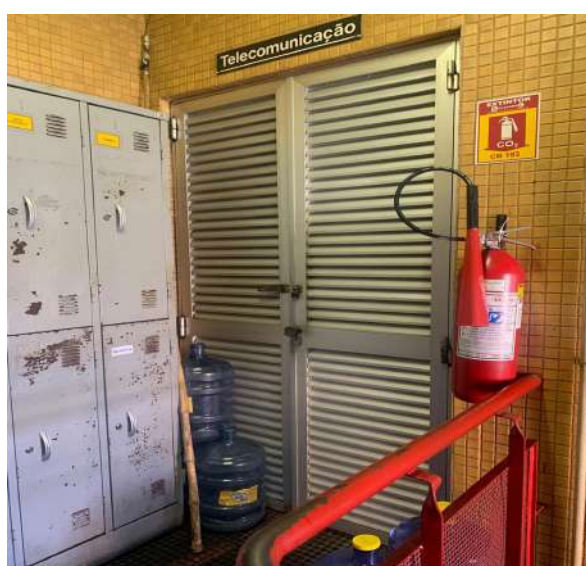
Exemplo de esquadrias de alumínio com fechaduras a serem substituídas
