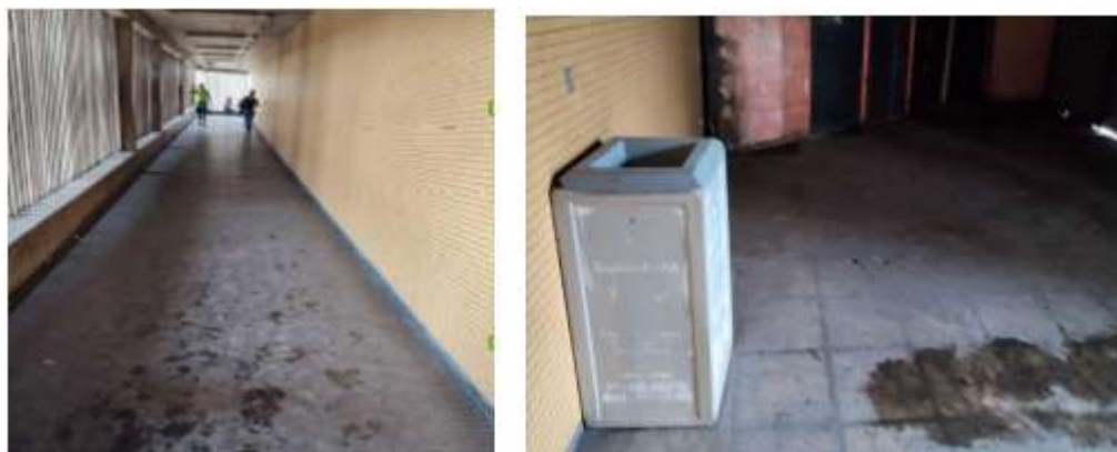
Exemplos de placas de piso emborrachado a serem substituídas na Estação Barro
