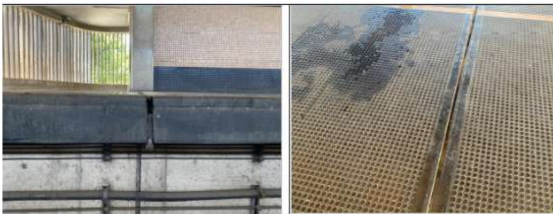
Imagem de juntas a serem substituídas no piso das plataformas da Estação Engenho Velho
