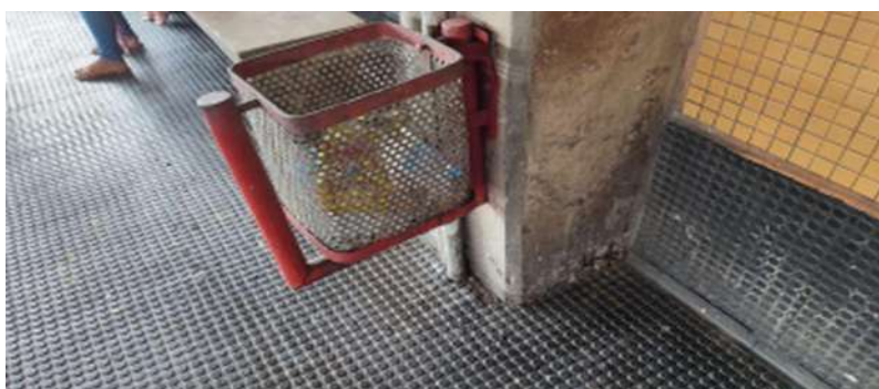
Situações onde os pilares serão recuperados e os rodapés substituídos na Estação Barro
