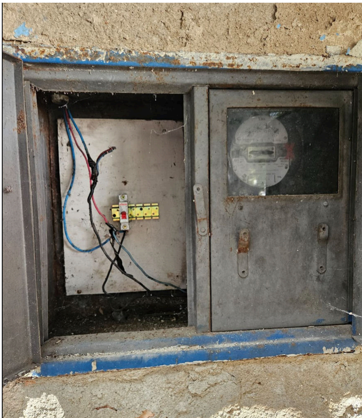
disjuntor geral de energia da casa
