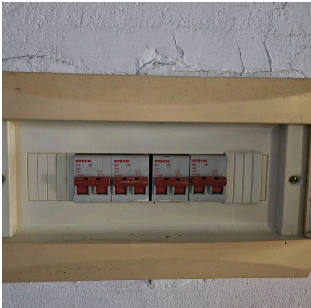
quadro de distribuição de energia, disjuntores
