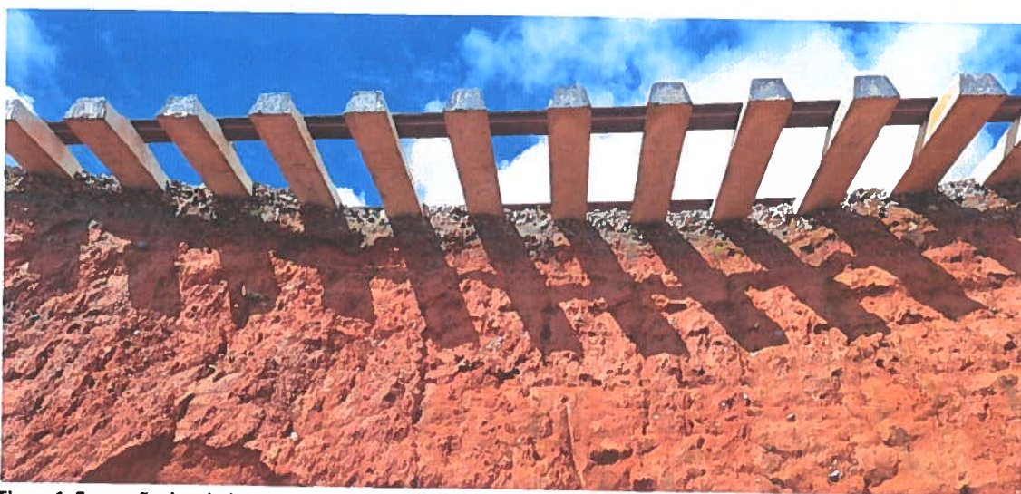
Figura 1: Escavação do talude acima da região de rompimento da adutora
