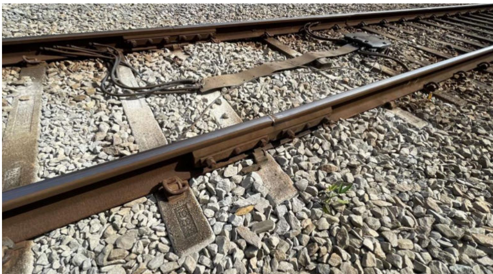
Foto 05: Outra vista de trecho com visível colmatção de lastro
