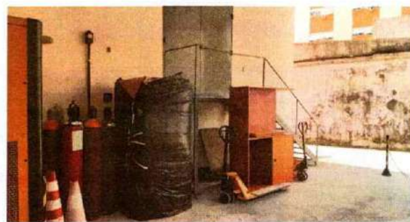
Armazenamento de cilindros em local não apropriado
