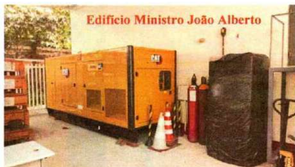
Armazenamento de cilindros em local não apropriado
