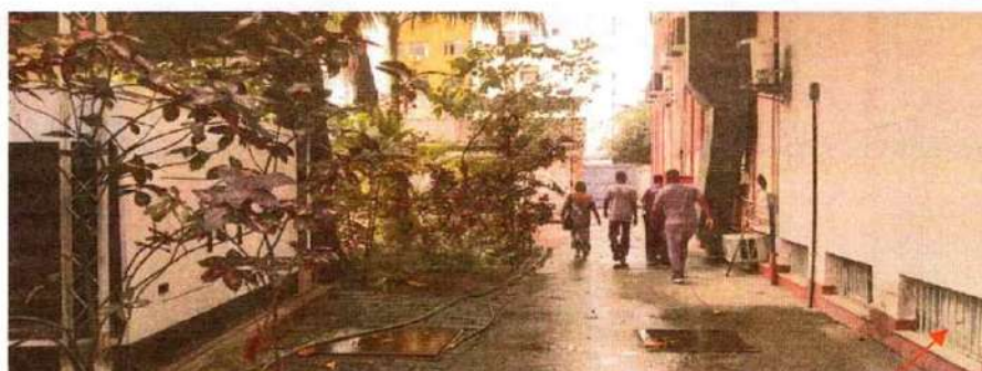
Edifício Ministro João Alberto
