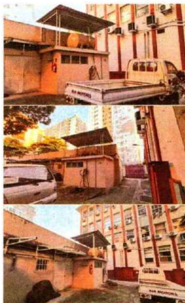
Armazenamento de óleo diesel está em local não apropriado.
