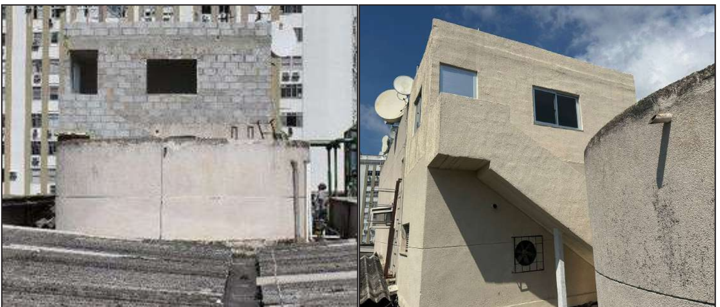
Figura 9: Construção da estrutura para o projeto Rede Rio Quântica
