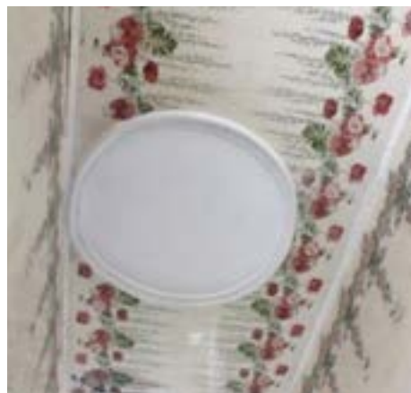
Figura 7 – Forro do primeiro pavimento após a remoção da escada de serviço. Fonte: acervo pessoal de Caroline M. F. Rodrigues, 2018.
