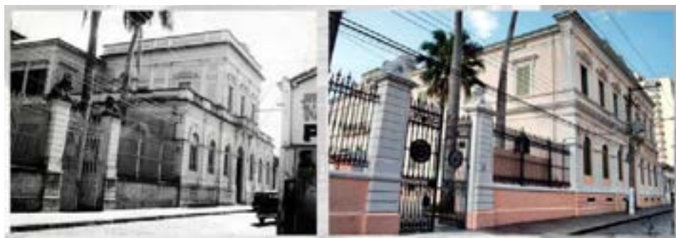
Figura 11 – Fotografias da fachada frontal do Palácio Itapura. À esquerda: nota-se a presença das varandas originais. À direita uma fotografia da condição atual do edifício. Fonte: Projeto Restauo (PUC-Campinas).
