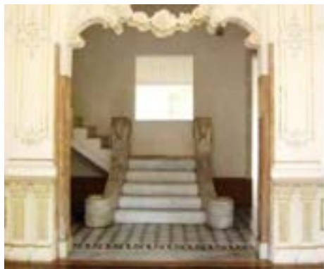
Figura 3 – Escada Social em mármore com seus arranques em forma de leão. Fonte: Palacete Bolonha .
