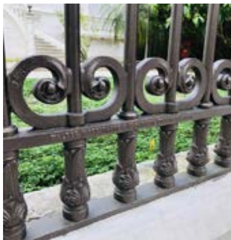
Figura 5 – Detalhe do portão no gradil externo do Parque da Residência. Fonte: acervo próprio (registro em: 20 de maio de 2019).
