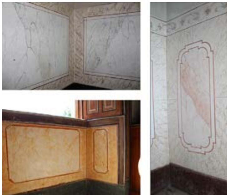
Figura 4 – Detalhes das escaiolas dos quatro dormitórios masculinos. Fonte: fotos da autora.
