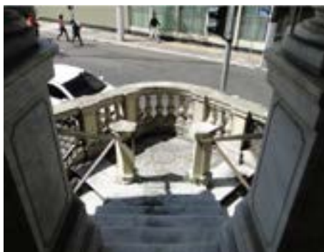
Figura 11 – Escada social que não é mais utilizada como acesso principal ao edifício. Fonte: acervo pessoal de Caroline M. F. Rodrigues, 2018.
