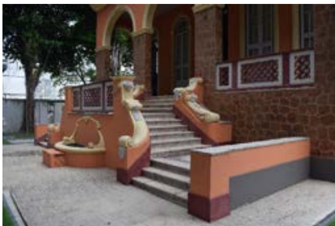
Figura 12 – Detalhe da escada frontal. Fonte: fotografia de Matheus Gonçalves Nunes (2019).
