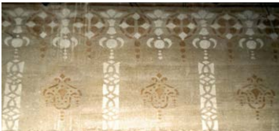
Figura 12 – Pintura decorativa provavelmente na técnica de estêncil do quarto de casal. Fonte: acervo pessoal da autora.
