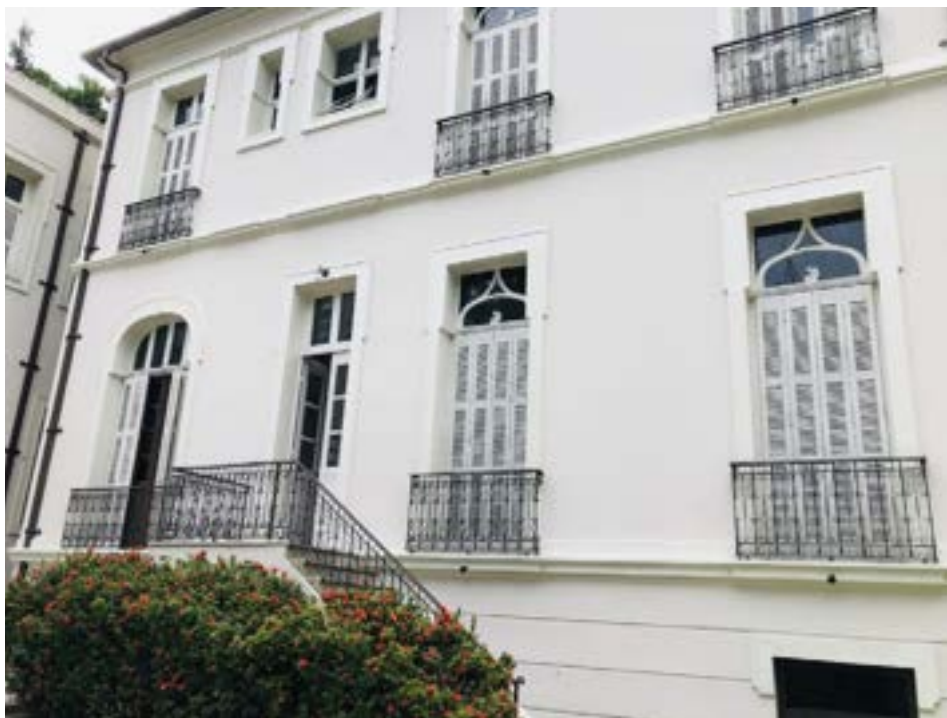
Figura 13 – Fachada posterior da edificação. Fonte: acervo próprio (registro em: 20 de maio de 2019).
