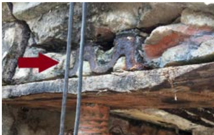
Figura 2 – Destaque para o trilho metálico na estrutura da laje. Fonte: Beatriz Maneschy, 2018.
