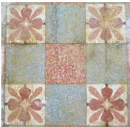
Figura 15 – Ladrilhos hidráulicos decorados e lisos do piso da sala de almoço. Fonte: acervo pessoal da autora.
