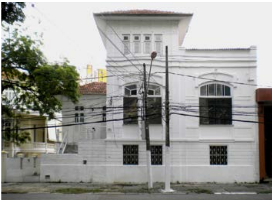
Figura 5 – Palacete Orlando Lima. Em primeiro plano, porão habitável e janelas do primeiro pavimento. Ao fundo, escada de acesso ao setor social. Fonte: acervo pessoal de Dulcília Acatauassu Nunes (2017).
