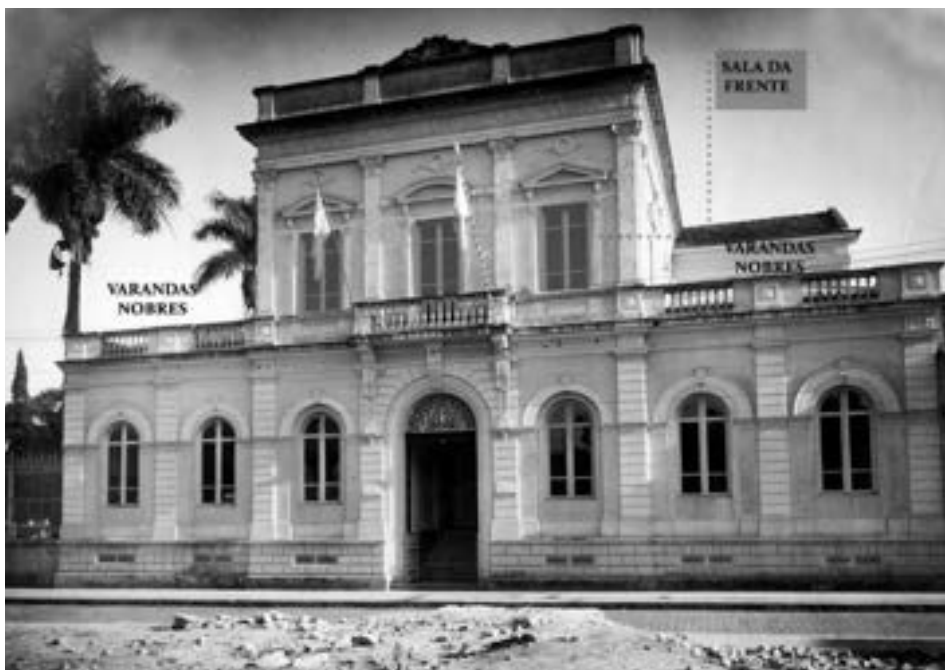
Figura 10 – Foto da fachada principal do Palácio Itapura, identificando os ambientes no segundo pavimento do edifício. Fonte: Formarte, Campinas. Editada pelas autoras.
