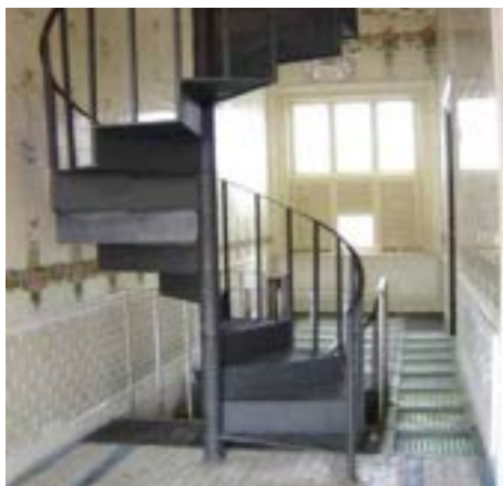
Figura 6 – Escadas de serviço helicoidais que ligavam o térreo e o segundo pavimento. Fonte: Palacete Bolonha .
