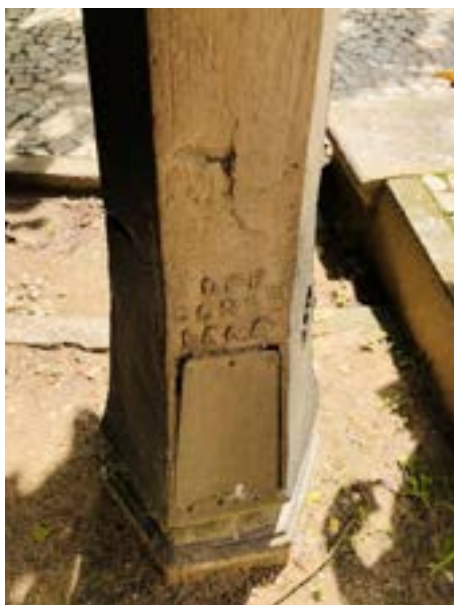
Figura 6 – Detalhe do poste de iluminação que até hoje se encontra no Parque da Residência. Fonte: acervo próprio (registro em: 20 de maio de 2019).
