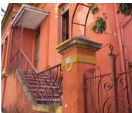
Figura 8 – Salão Vivacqua. Entrada lateral principal, escadaria. Construção: 1909; Arquiteto: Edgard Nascentes Coelho. Atual sede do Museu da Cadeira Brasileira. Fonte: acervo pessoal.
