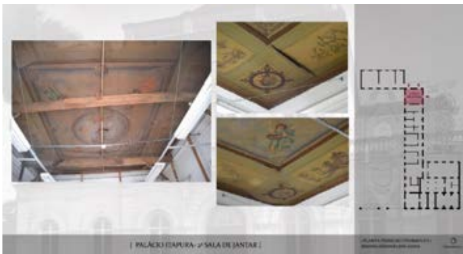
Figura 7 – Fotografias do forro de tela da 2ª sala de jantar do Palácio Itapura. Fonte: acervo pessoal das autoras.
