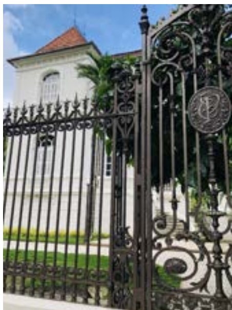
Figura 7 – Detalhe do portão e brasão presente no gradil externo do Parque da Residência. Fonte: acervo próprio (registro em: 20 de maio de 2019).
