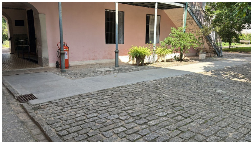
Figura 3 – Via pedonal acessível
