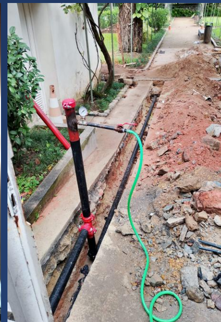
Figura 13 - Instalação de tubulação de água pressurizada para incêndio
