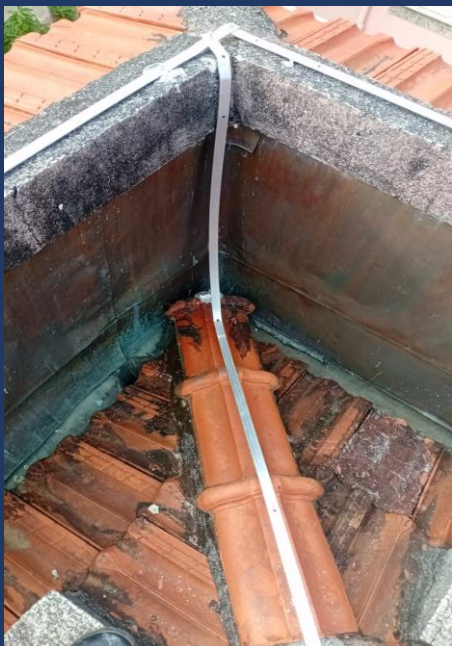
Figura 9 - Detalhe da instalação do SPDA junto ao telhado do MCRB
