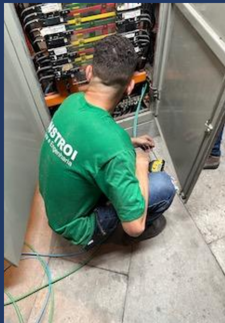
Figura 10 - Novo quadro geral elétrico sendo instalado
