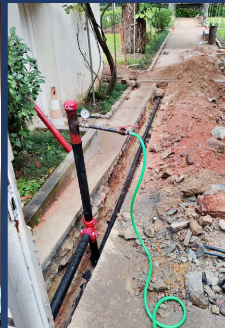
Figura 13 - Instalação de tubulação de água pressurizada para incêndio
