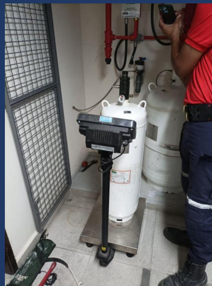
Figura 20 - Pesagem dos cilindros de FM200
