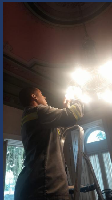
Figura 12 - Reinstalação dos lustres após restauração técnica
