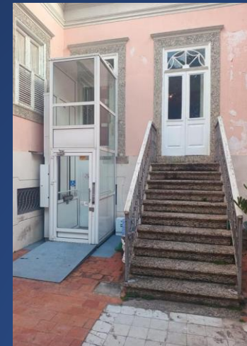
Figura 8 - Inserção de plataforma elevatória no MCRB
