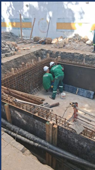
Figura 11 - Construção da RTI
