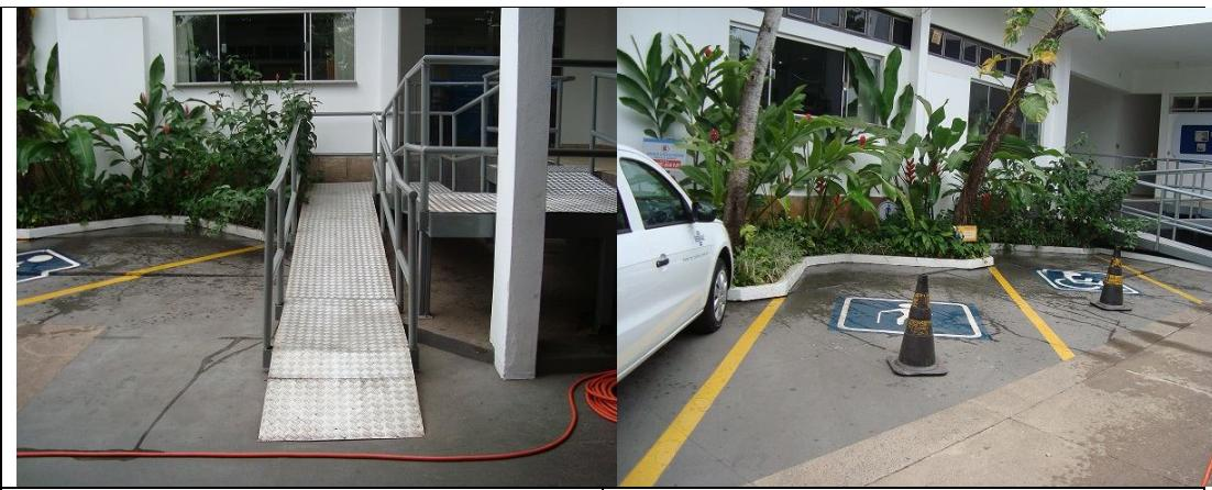
Foto da rampa não atendendo as Normas da ABNT-NBR-9050 na largura e nos corrimãos.
