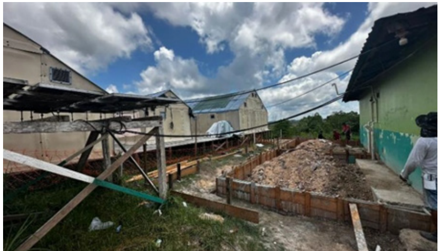
Foto 02 – fundações do bloco 01 – Ampliações de estruturas
