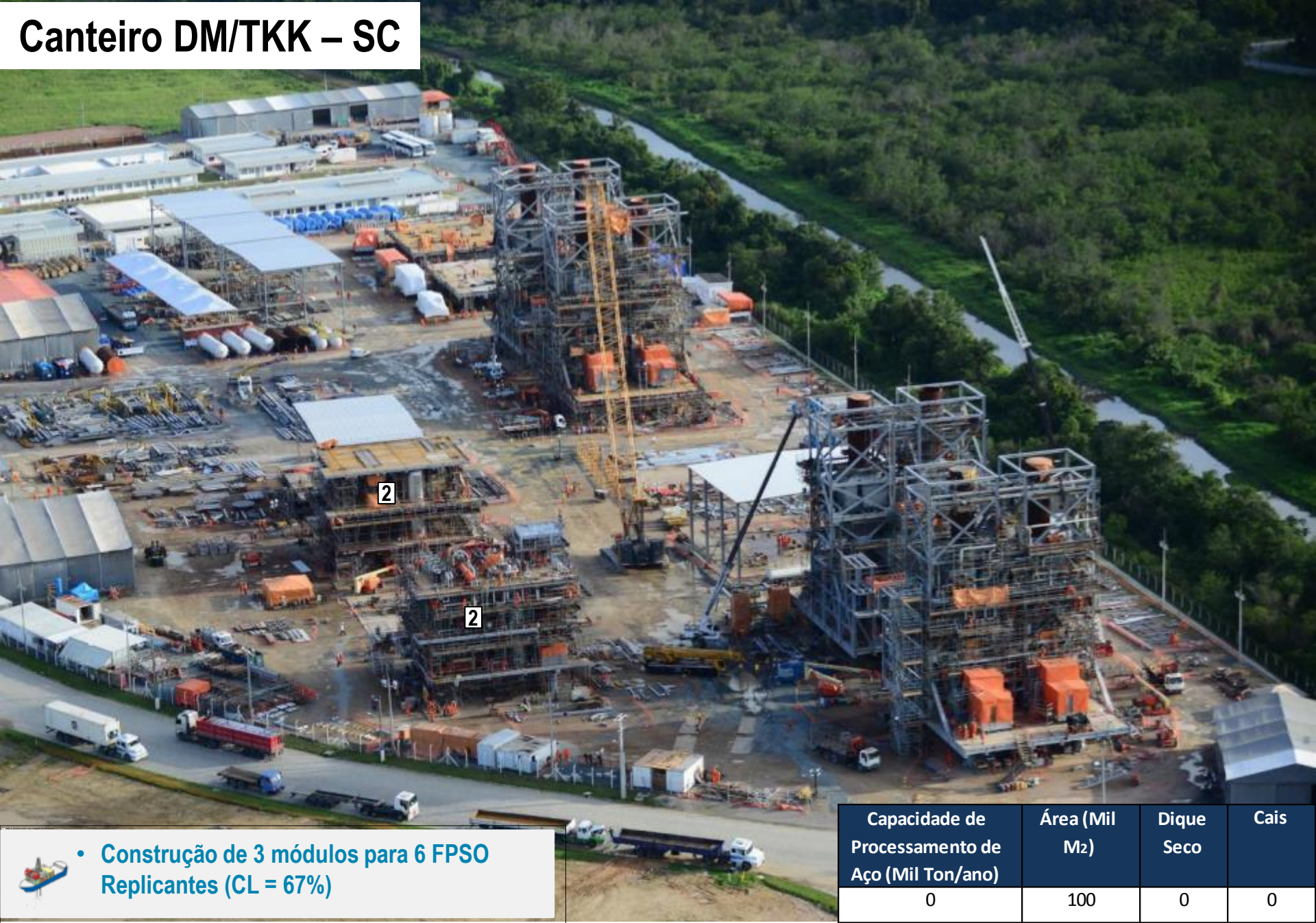
Vista Geral do Canteiro DM/TKK, em Itajaí – SC (dez/14) (1) Módulos de Geração de Energia; (2) Módulos de Gás Combustível e Desidratação de Gás
