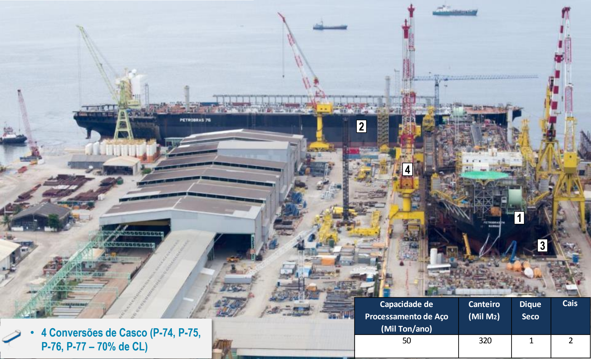
Vista Geral do Estaleiro Inhaúma, no Rio de Janeiro – RJ, com as obras de conversão do casco P-74 e P-76 (Mar/15). (1) Conversão do navio VLCC no casco da P-74; (2) Serviços de acabamento da conversão da P-76 após trabalhos na China (3) Dique seco recuperado em 2012 pela Petrobras; (4) Novos guindastes de 100 e 400 toneladas, instalados em novembro de 2013.
