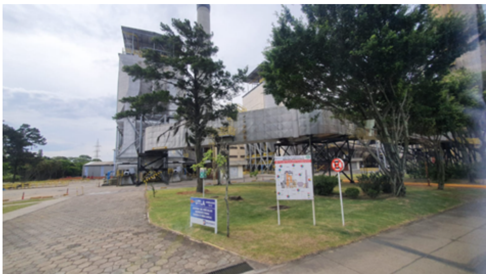
Central Termelétrica Jorge Lacerda
