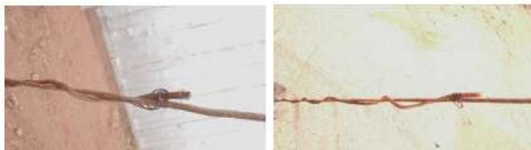
Figura 11 e 12 Cabo de aço amarrado com arame.
