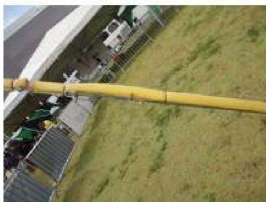
Figura 5 e 6 Cabo de aço com proteção com macarrão de piscina.
