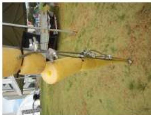
Figura 5 e 6 Cabo de aço com proteção com macarrão de piscina.
