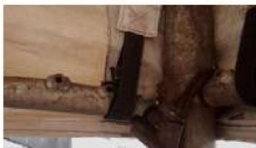
Figura 13 e 14 Estrutura da tenda quebrada e amarrada com corda.
