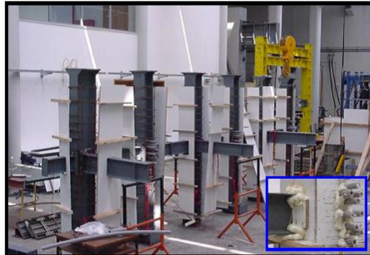
(d) Vista geral durante a montagem da forma.
