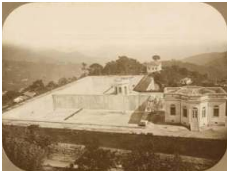
Obras do abastecimento d'água do Rio de Janeiro: reservatório de Santa Thereza. Por Marc Ferrez, 1877-1882. Acervo da Biblioteca Nacional.
