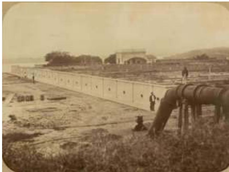
Reservatório de D. Pedro II - morro do Pedregulho. Vista Geral, 1882. Obras do abastecimento d'água do Rio de Janeiro. Empresa - A. Gabrielli. Acervo da Biblioteca Nacional.
