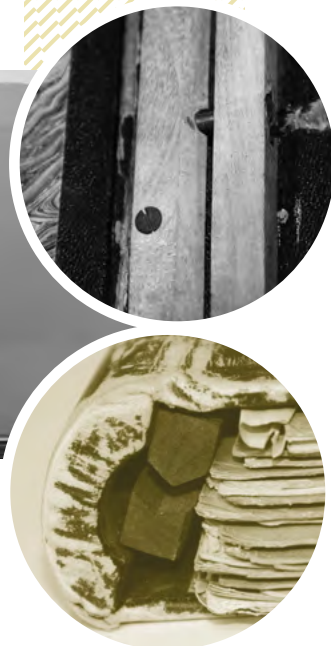
Figura 7. Detalhes do pino de metal e do encaixe das peças de madeira. Fonte: Fundação Biblioteca Nacional. Divisão de Iconografia.
