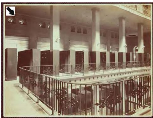
Armazém de livros / BN indicando os locais das ‘escotilhas’ de ventilação, com salão de leitura na base – 1909.
