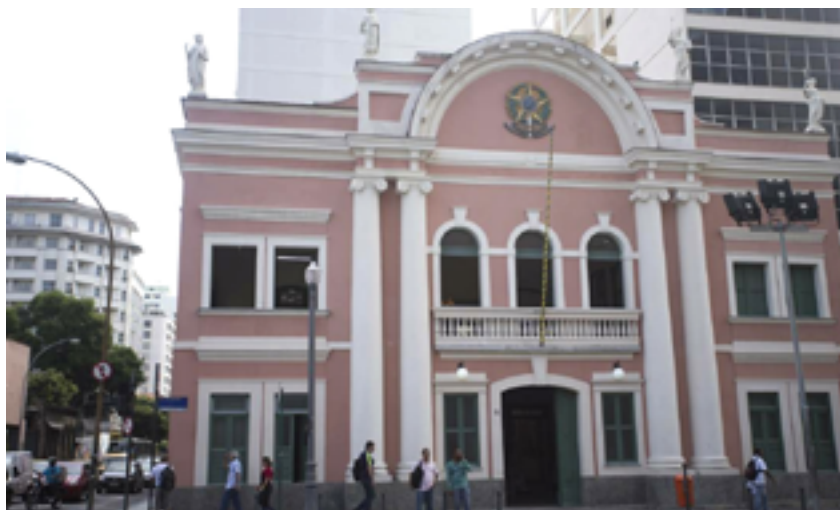
Figura 1 – Fachada do edifício da Casa da Suplicação do Brasil 6
