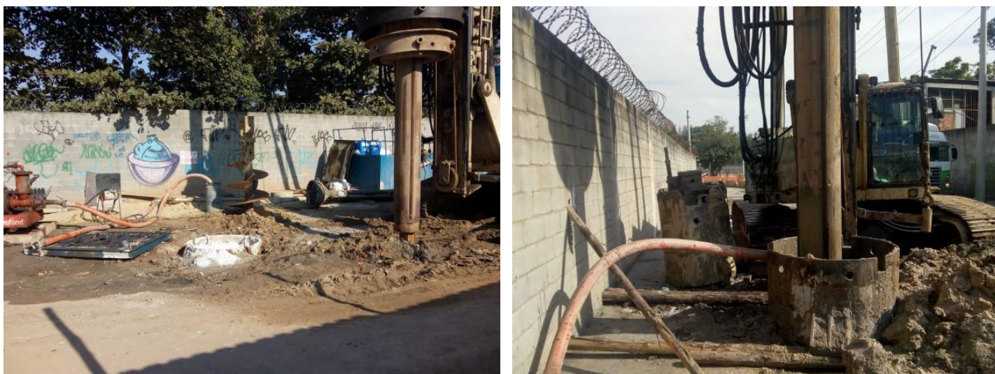
Execução de fundação.
