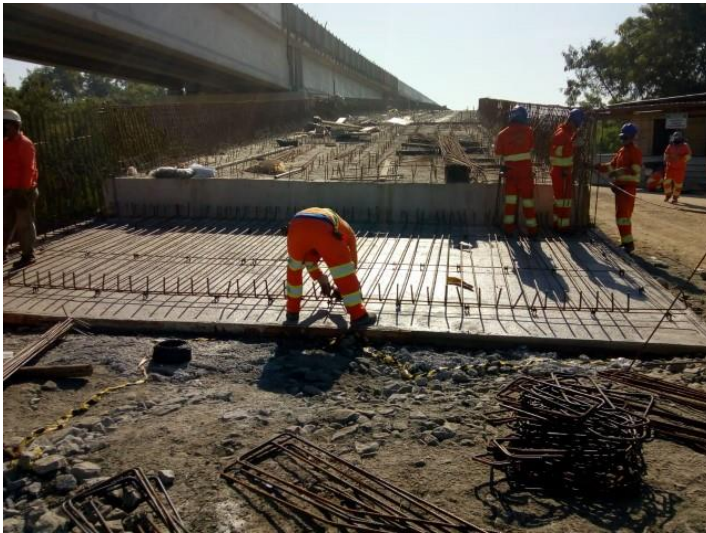
Execução da armadura.
