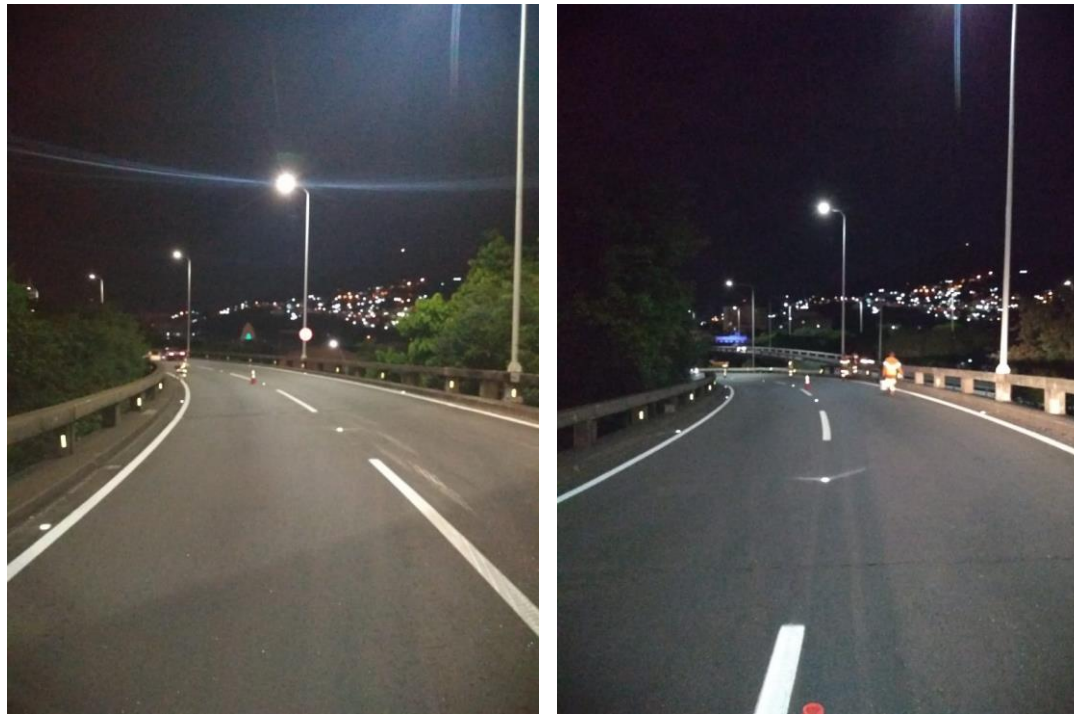
Instalação das taxas refletivas.
