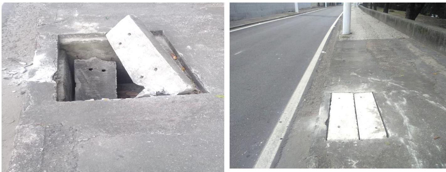
Substituição das tampas do sistema de drenagem.
