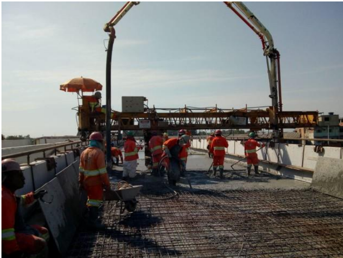
Concretagem da laje.
