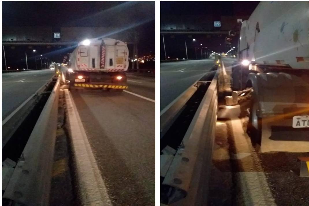
Varrição mecanizada no trecho sobre o mar.
