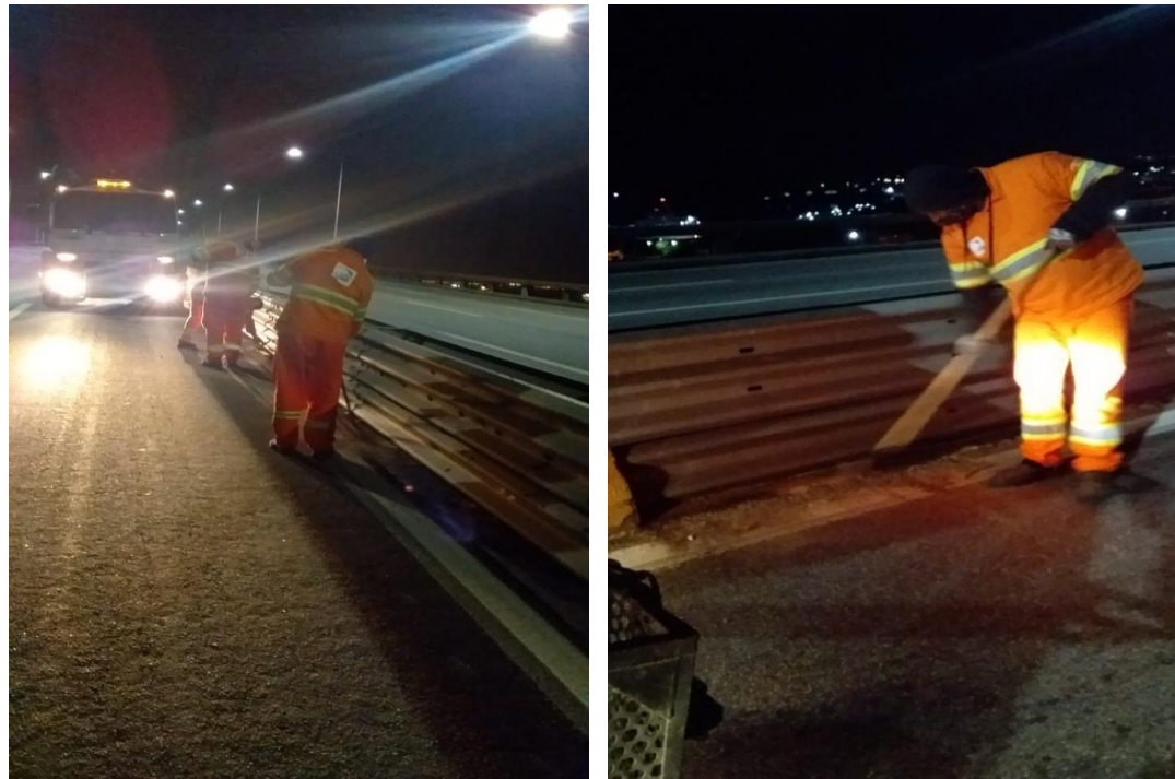
Varrição manual do trecho sobre o mar.
