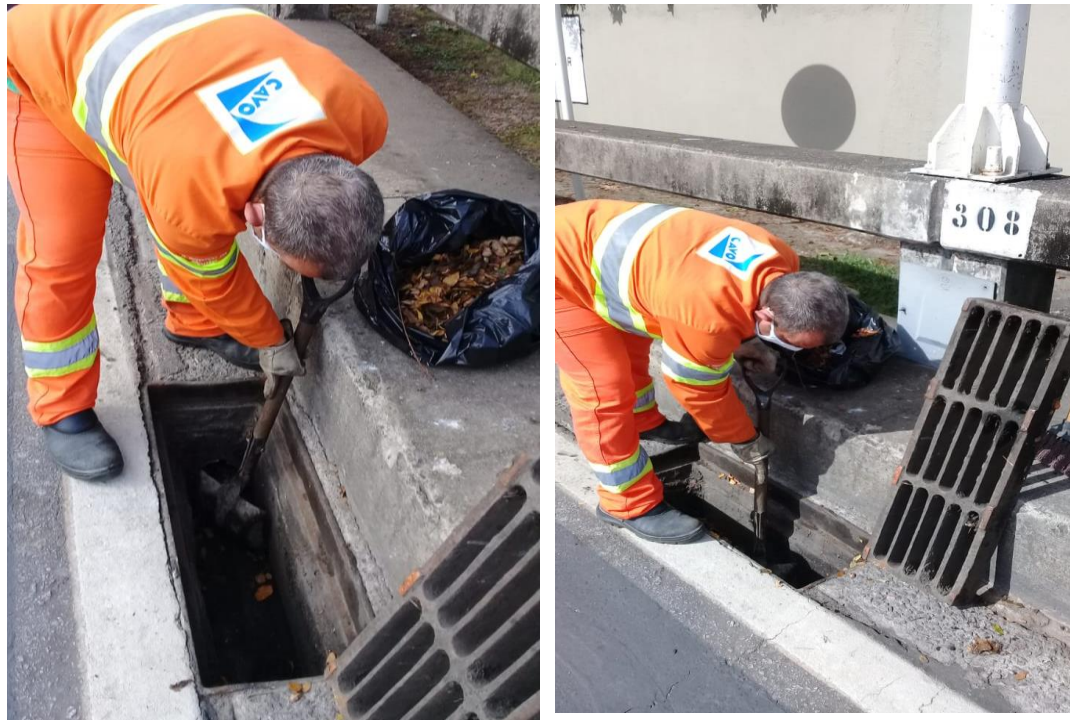
Limpeza manual do sistema de drenagem.
