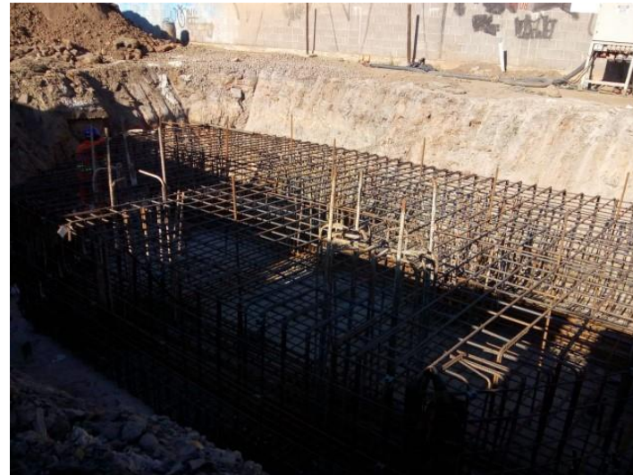
Execução de bloco de fundação.
