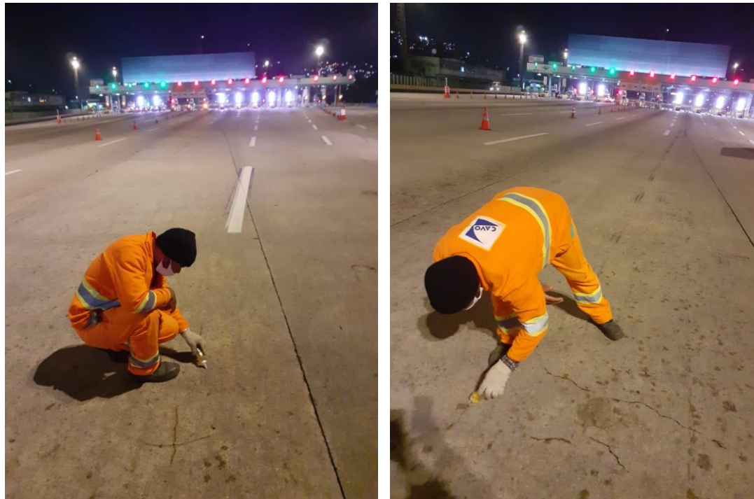
Selagem do pavimento rígido.
