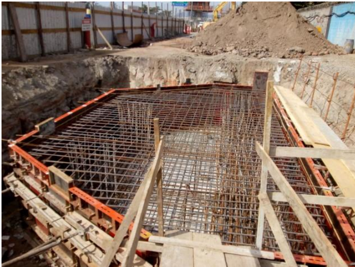
Execução de bloco de fundação.
