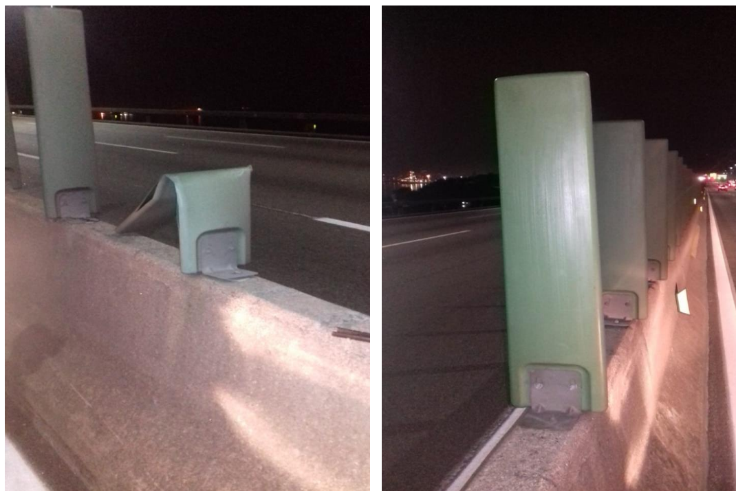
Substituição da lamela antiofuscante.
