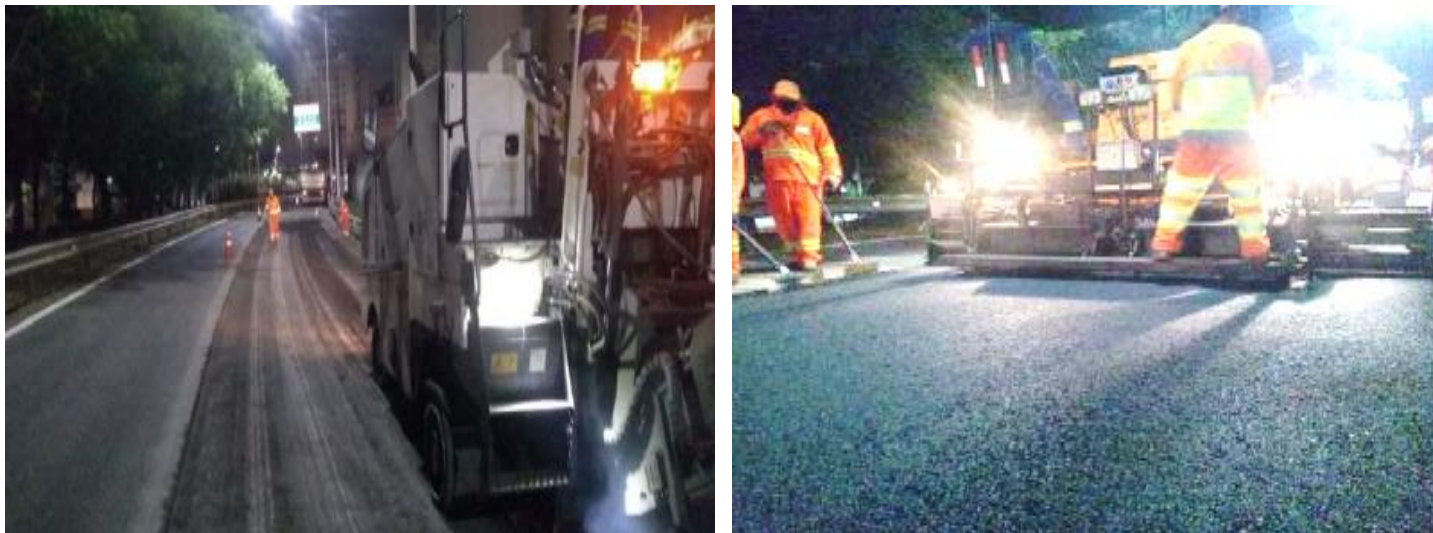
Recuperação do pavimento flexível.
