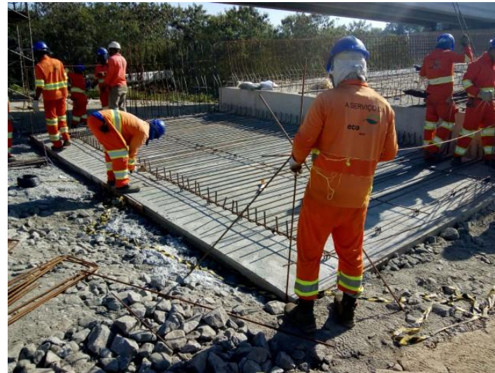
Execução da armadura.
