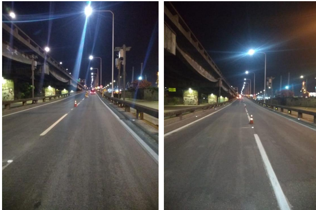
Instalação das taxas refletivas.
