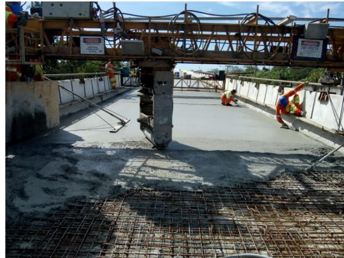
Concretagem da laje.
