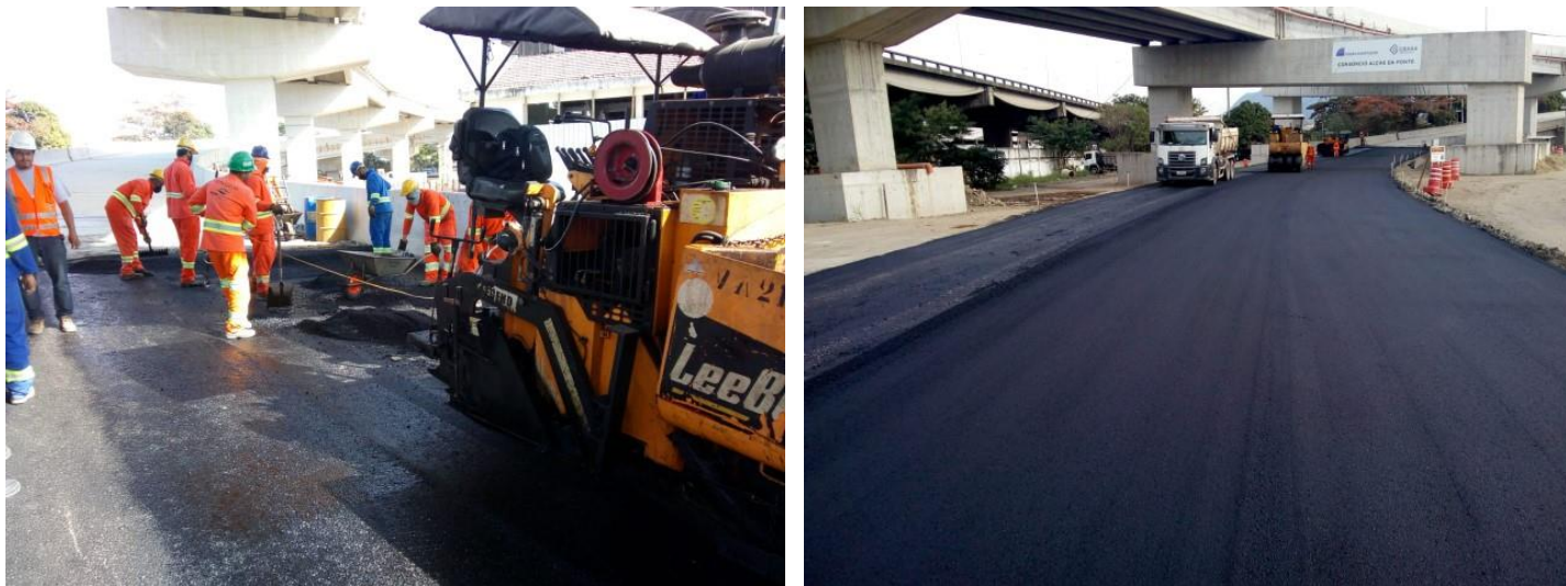
Realização do pavimento.
