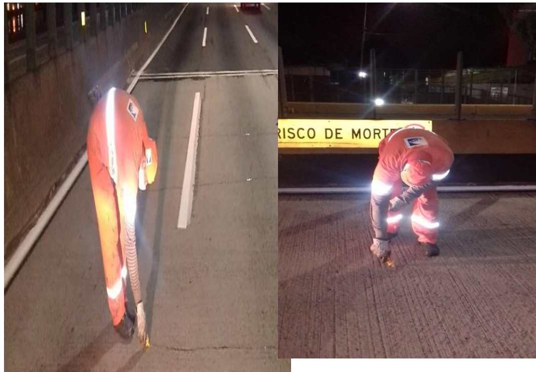
Selagem do pavimento rígido.
