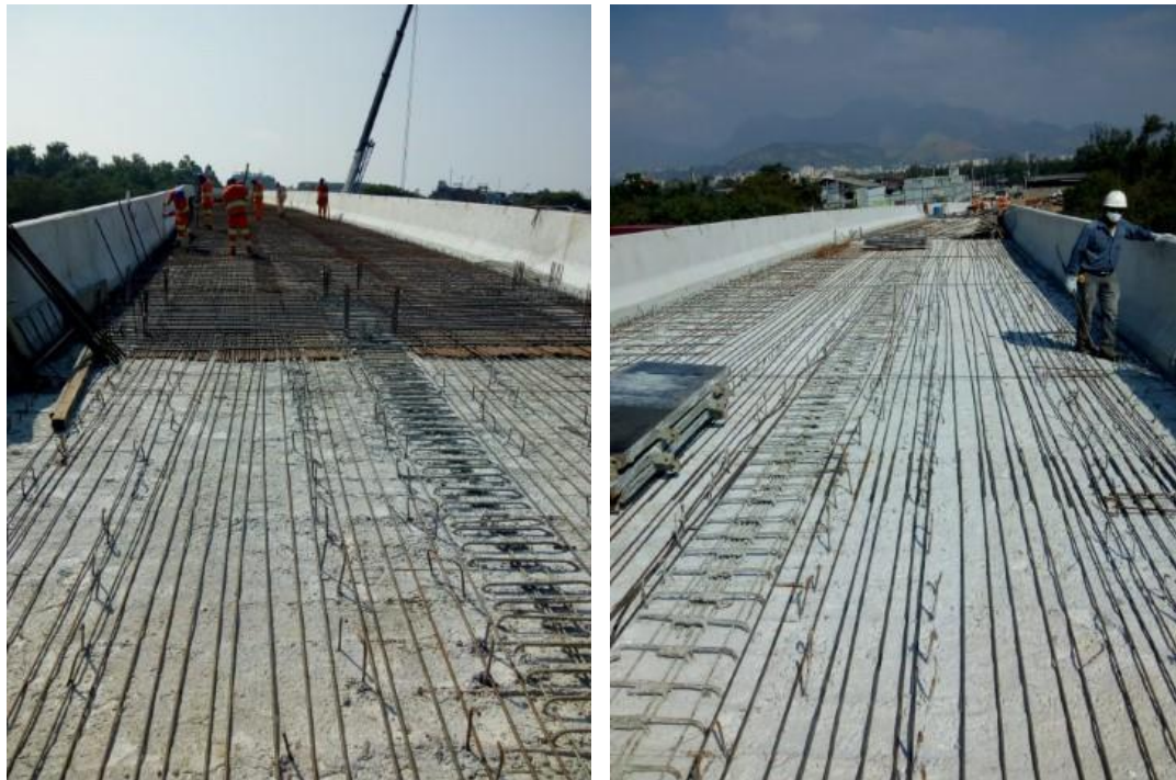
Execução da armadura.
