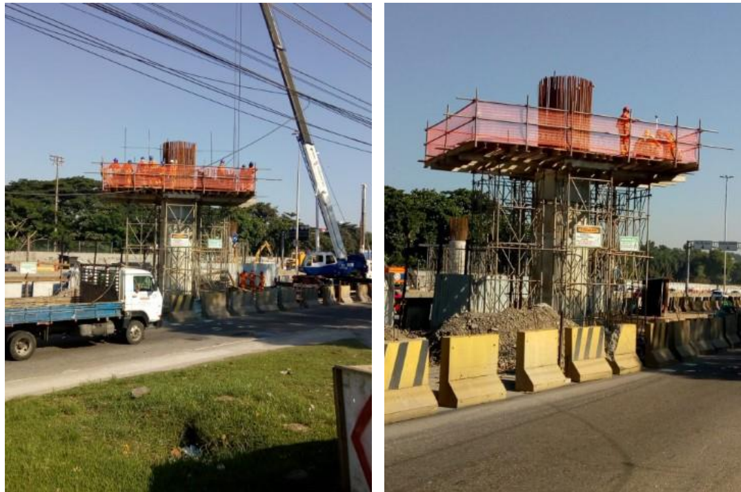
Execução de pilar e travessa.
