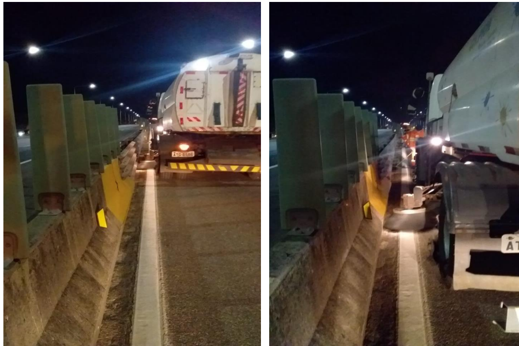
Varrição mecanizada no trecho sobre o mar.
