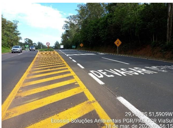
Figura 15 - Sinalização horizontal para redução de velocidade. Fonte: Ecossis, 2022.
