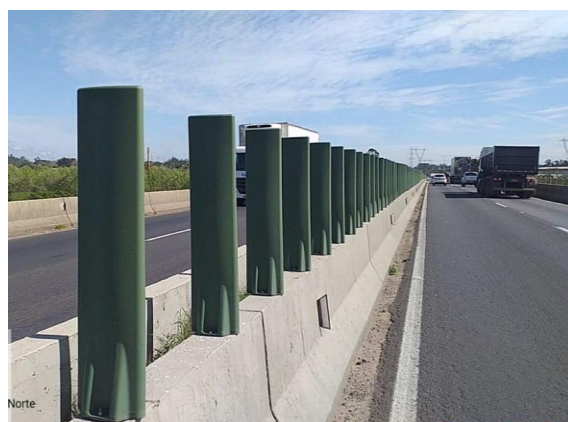
Figura 31 – Sinalização com lamelas antiofuscantes nas BR-101 e BR-386. Fonte: CCR ViaSul, 2022.
