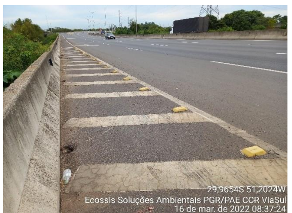
Figura 23 – Tachões instalados ao longo dos trechos percorridos. Fonte: Ecossis, 2022.
