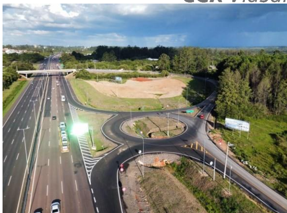
Figura 28 – Interconexão do tipo trombeta instalado no km 80+070 da BR-290. Fonte: CCR Via Sul, 2022.
