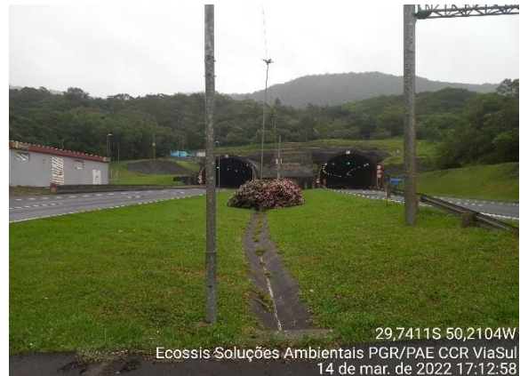
Figura 26 – Sistema de condução de águas pluviais para drenagem. Fonte: Ecossis, 2022.
