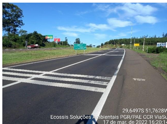
Figura 16 – Linhas de estímulo a redução de velocidade. Fonte: Ecossis, 2022.
