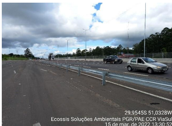
Figura 21 – Balizadores utilizados como dispositivos delimitadores. Fonte: Ecossis, 2022.
