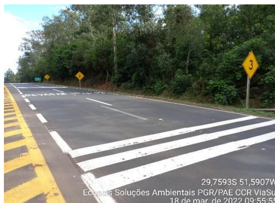
Figura 18 – Sinalização horizontal para redução de velocidade. Fonte: Ecossis, 2022.
