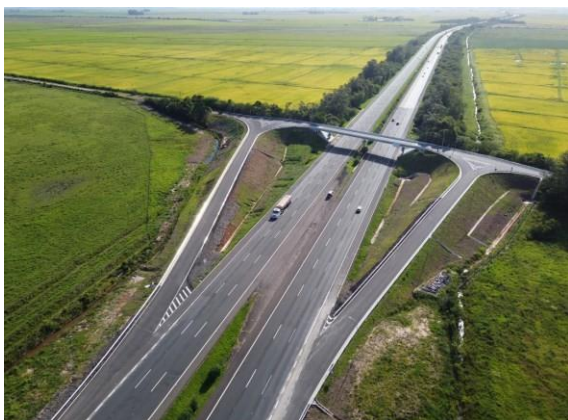
Figura 27 – Interconexão do tipo diamante instalada no km 32+170 da BR-290. Fonte: CCR Via Sul, 2022.
