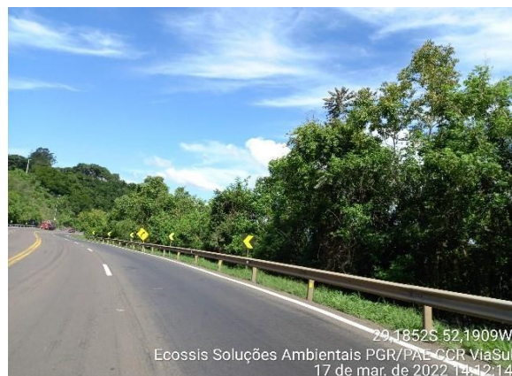
Figura 20 – Marcadores de alinhamento instalados como dispositivos auxiliares. Fonte: Ecossis, 2022.
