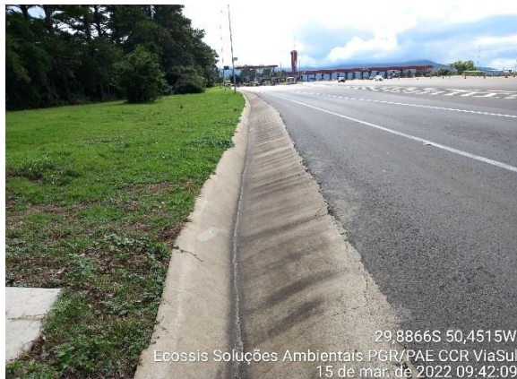
Figura 25 – Dispositivos de drenagem de águas instalados ao longo dos trechos. Fonte: Ecossis, 2022.
