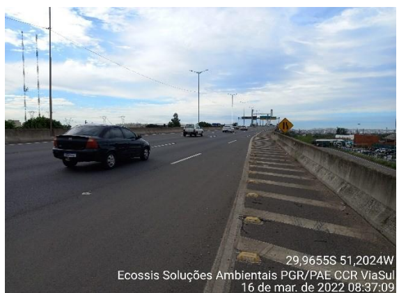
Figura 24 – Tachões utilizados como dispositivos delimitadores. Fonte: Ecossis, 2022.
