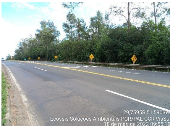
Figura 19 - Marcadores de alinhamento instalados como dispositivos auxiliares. Fonte: Ecossis, 2022.
