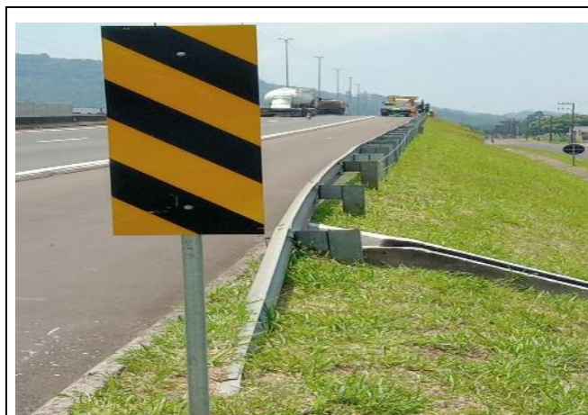
Foto 3 – Implantação de marcador de perigo no km 444, norte da BR-101/SC. (Entrega dos trabalhos iniciais, 31/01/2021)
