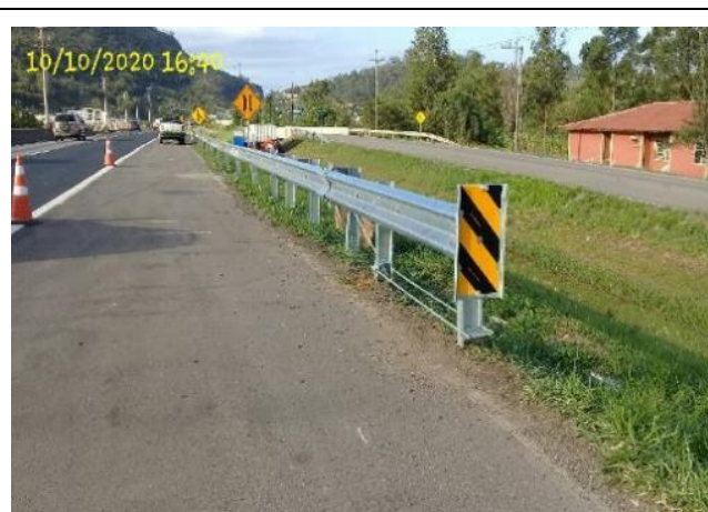
Foto 4 – Implantação de marcador de perigo no km 338, norte da BR-101/SC. (Entrega dos trabalhos iniciais, 10/10/2020)
