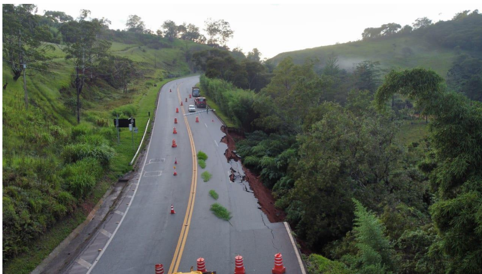
Figura 10: Vista do escorregamento de talude e rompimento da faixa de rolamento Km 745+000 Norte (antes-jan/23)
