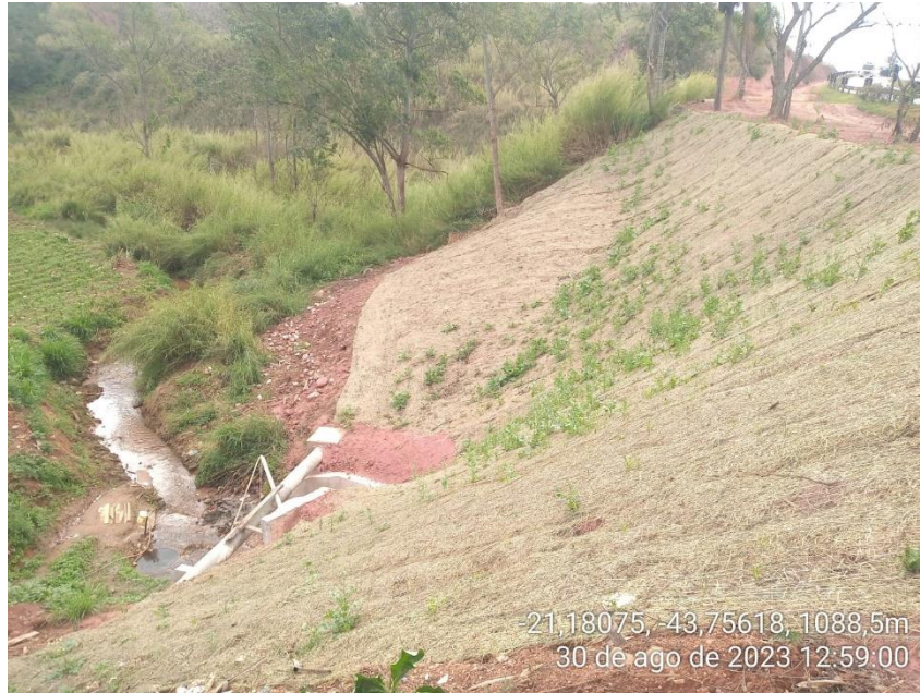
Figura 19: Recomposição de talude e revegetação em evolução Km 696+900 Sul (finalizada – set/23)
