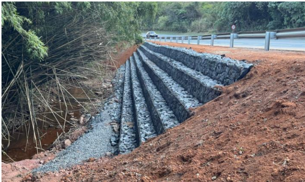
Figura 22: Recomposição de talude com gabião Km 750+050 Norte. (finalizada– set/23)
