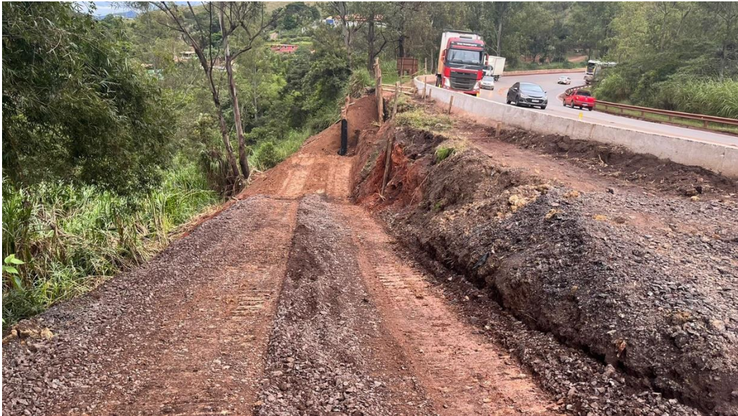
Figura 16: Recomposição de talude e revegetação Km 588+300 Norte (finalizado – set/23)
