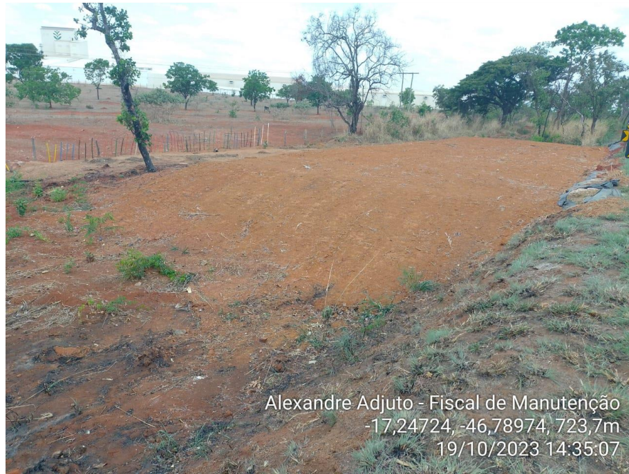
Figura 24: Recomposição da erosão e semeadura Km 51+470 Norte (finalizada– set/23)
