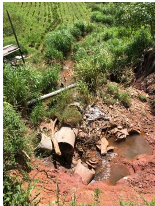
Figura 18: Vista do escorregamento de talude próximo a faixa de rolamento Km 696+900 Sul (antes-abr/23)
