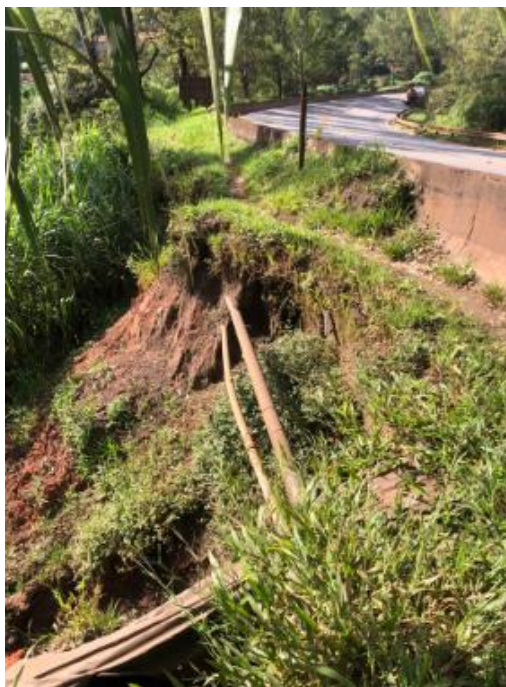
Figura 15: Vista do escorregamento de talude próximo a faixa de rolamento Km 588+300 Norte (antes-abr/23)
