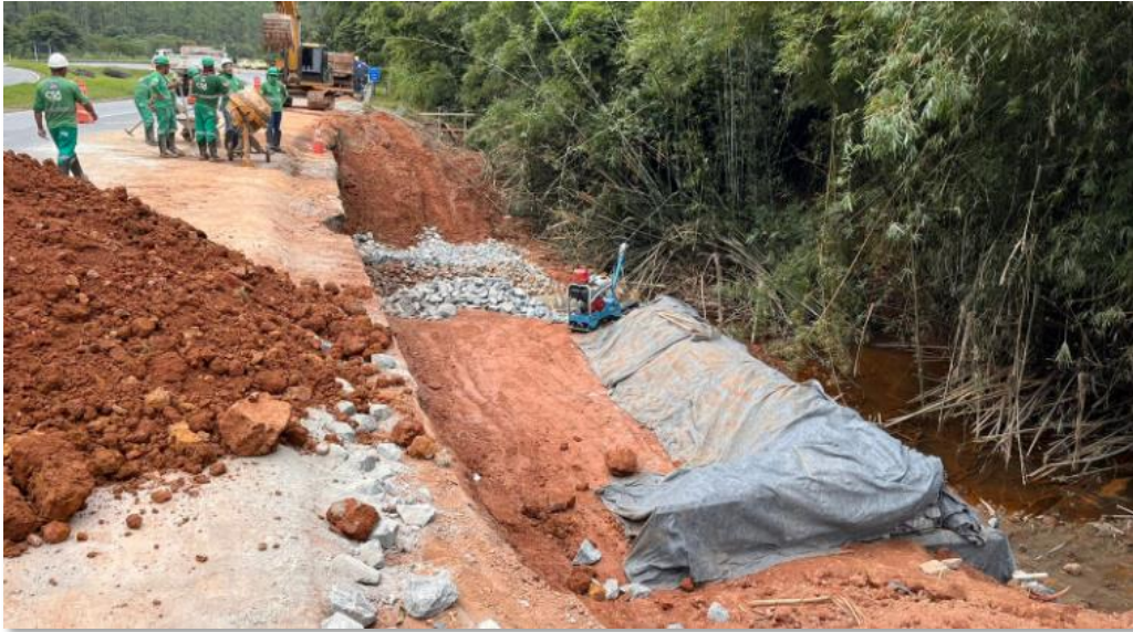
Figura 21: Recomposição de talude com gabião Km 750+050 Norte (finalizada – set/23)
