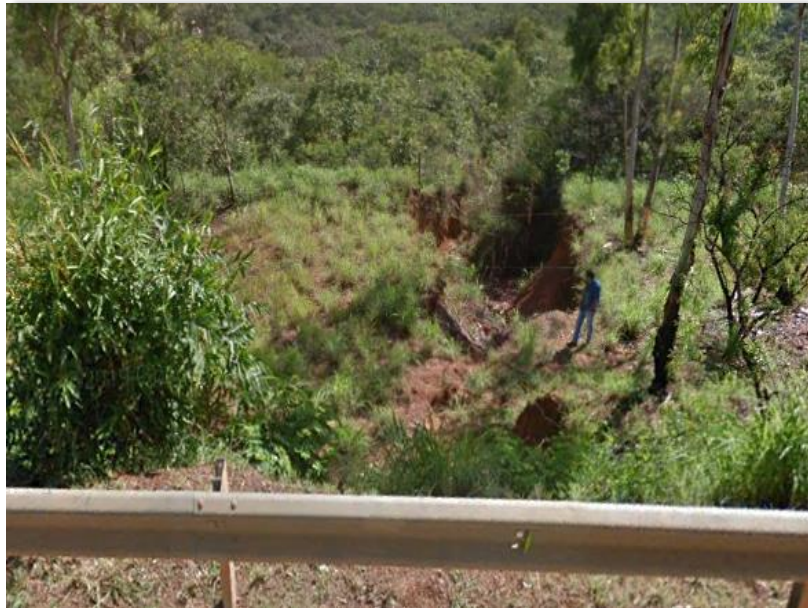
Figura 8: Processo erosivo a jusante do sistema de drenagem Km 033+050 Pista Norte (antes- Ago/21)
