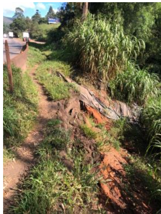
Figura 15: Vista do escorregamento de talude próximo a faixa de rolamento Km 588+300 Norte (antes-abr/23)
