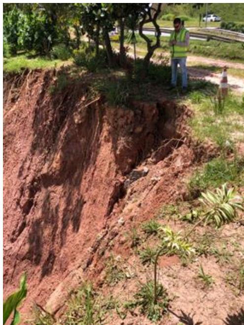
Figura 18: Vista do escorregamento de talude próximo a faixa de rolamento Km 696+900 Sul (antes-abr/23)
