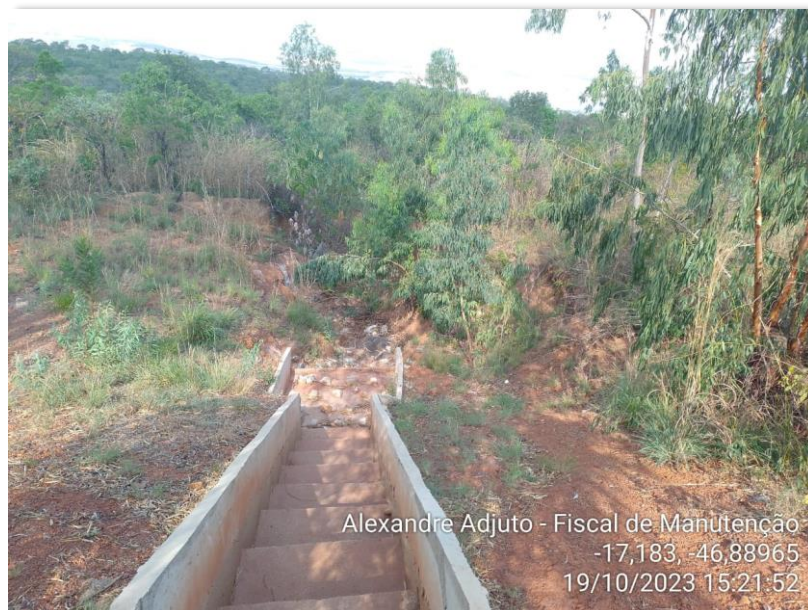
Figura 9: Drenagem, dissipador e recomposição vegetal Km 033+050 Pista Norte (finalizado - set/23)
