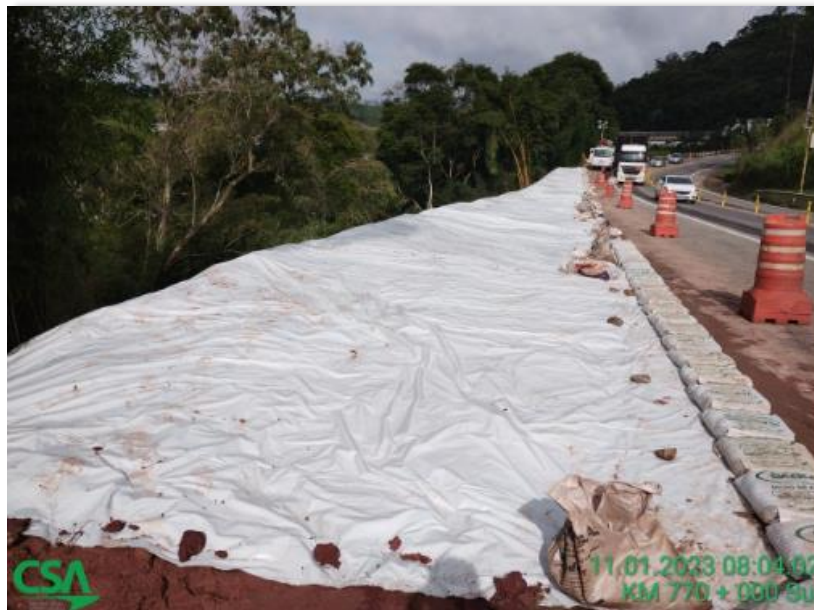
Figura 12: Reconstrução de talude Km 745+000 Norte (em andamento – mar/23)
